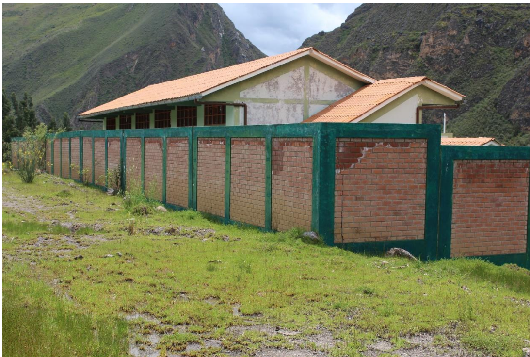
Anexo N° 03. Vista Posterior de los Elementos Estructurales del Cerco Perimétrico.
