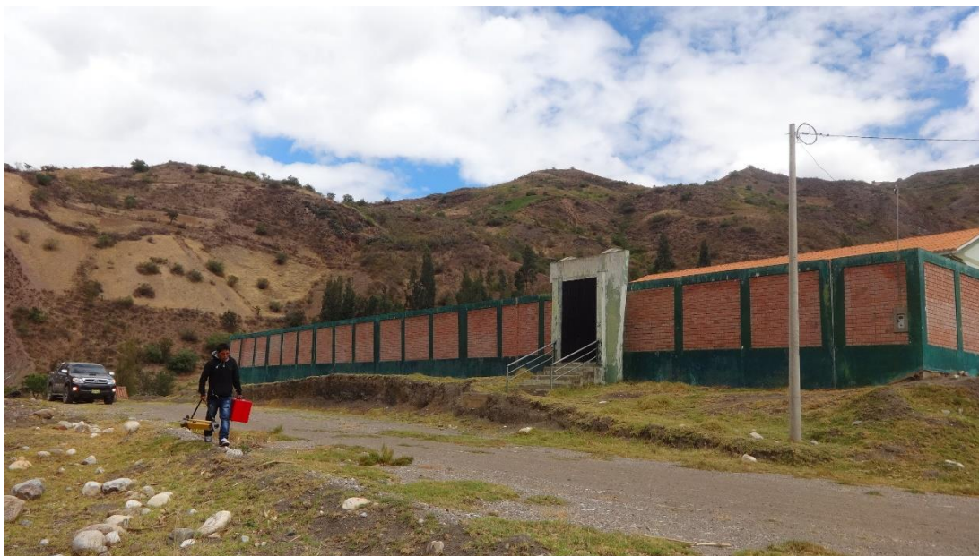
Anexos N° 01. Vista Frontal de los Elementos Estructurales del Cerco Perimétrico.
