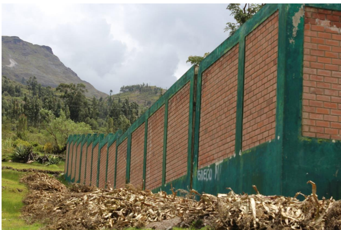
Anexo N° 04. Vista Lateral Izquierdo de los Elementos Estructurales del Cerco Perimétrico.
