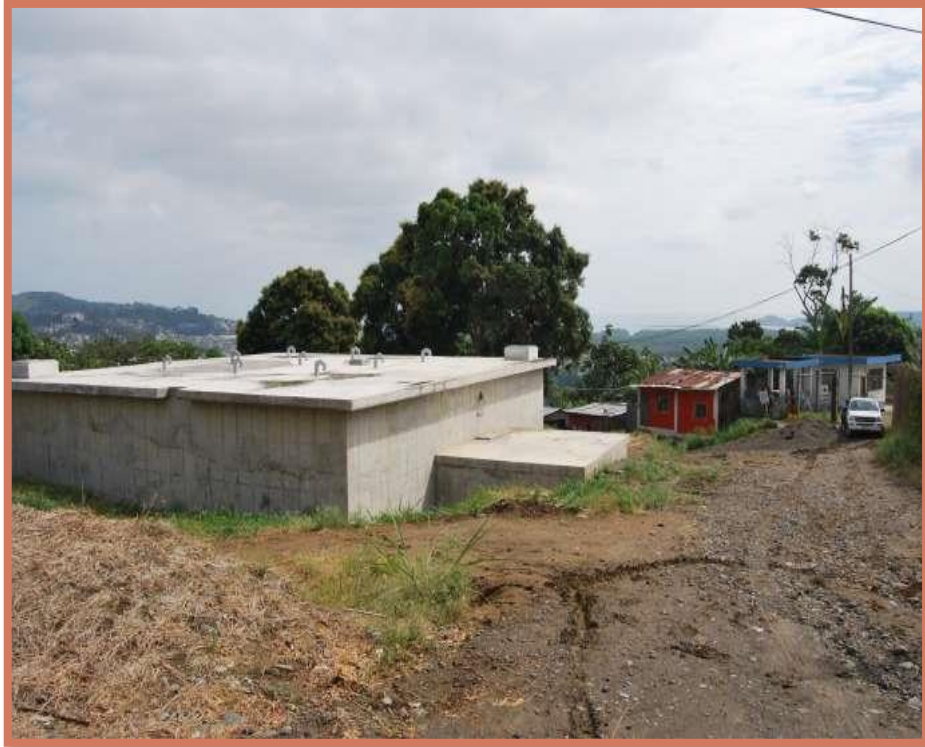
Gráfico 6: Reservorio rectangular con caseta de válvulas
