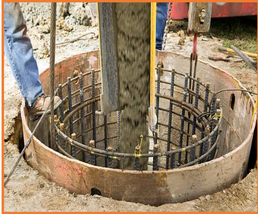
Gráfico 13: Esqueleto de un caisson de concreto
