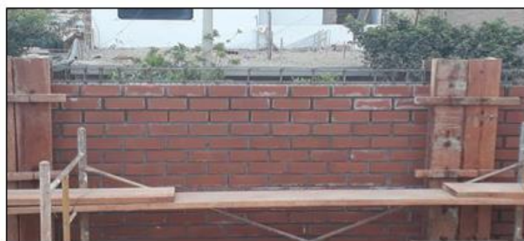
Figura 7. Viga de confinamiento
