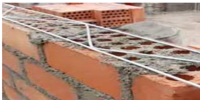
Figura 4. Albañilería armada
