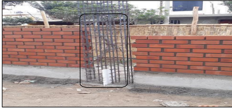
Figura 6. Columna de confinamiento
