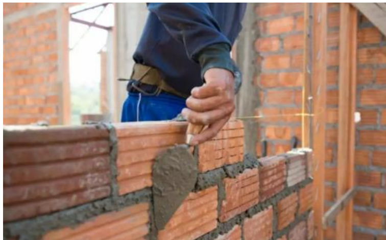
Figura 2. Albañilería simple Nota. Fuente: Guipúzcoa, I (9)
