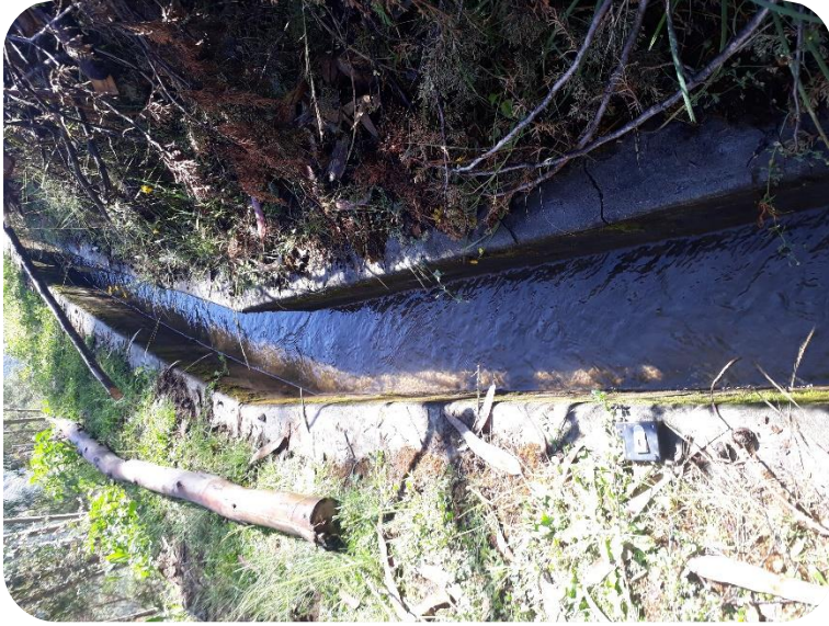
Fotografía 01: fotografía del canal en estudio.
