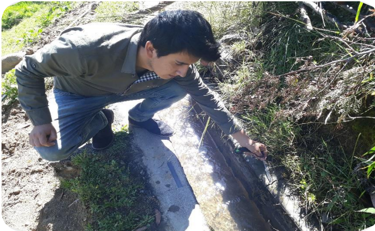
Fotografía 02: identificando patologías del concreto.
