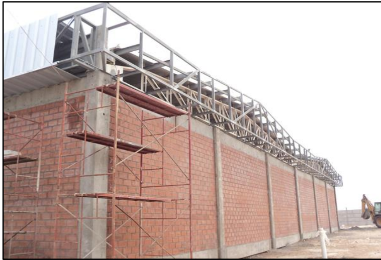
Figura 3. Albañilería confinada Nota. Fuente: (Rojas J. 2014) (11)
