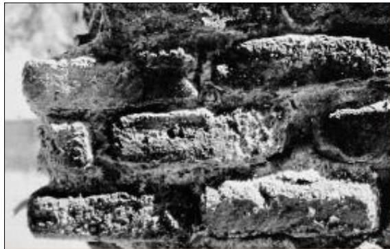
Figura 14. Erosión
