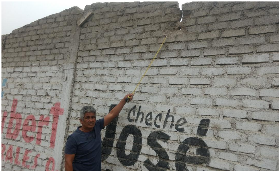
Fotografía 6. Desprendimiento en la unidad de muestra 09
