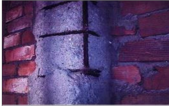
Figura 16. Corrosión
