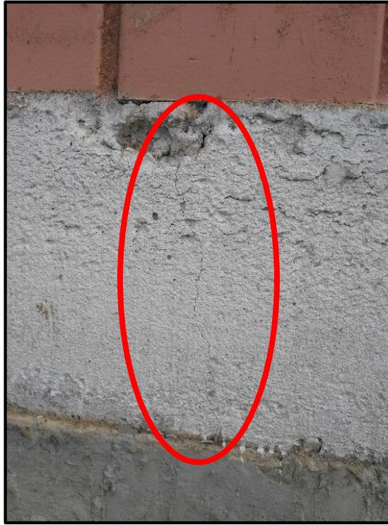
Figura 11. Fisura
