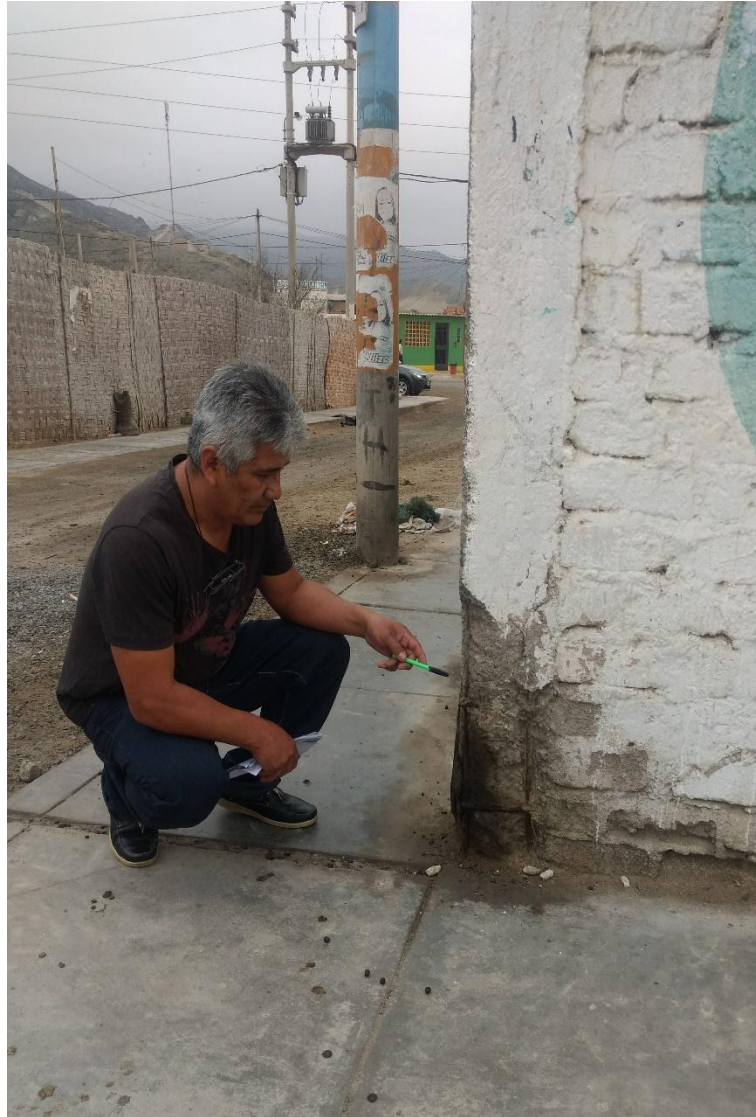
Fotografía 8. Corrosión en la unidad muestra 12
