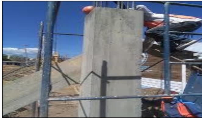
**Figura 11.** Columnas de concreto armado
