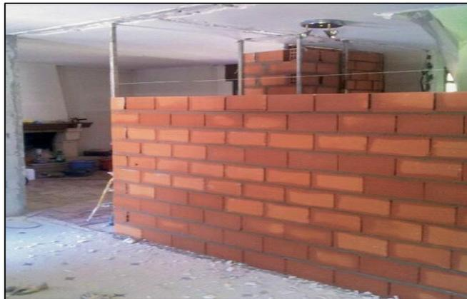
**Figura 9.** Muro No Portante
