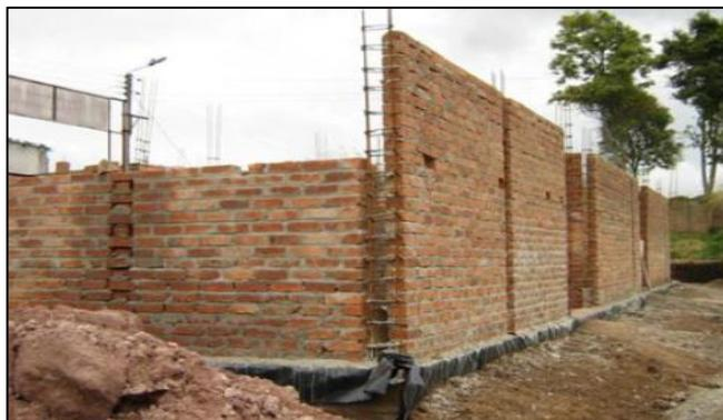
**Figura 3.** Albañilería simple o no reforzada
