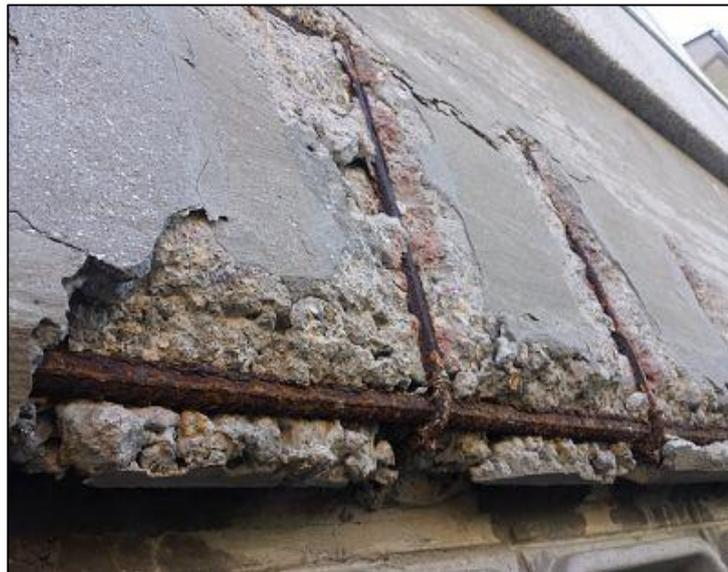
***Figura 26. Corrosión***
