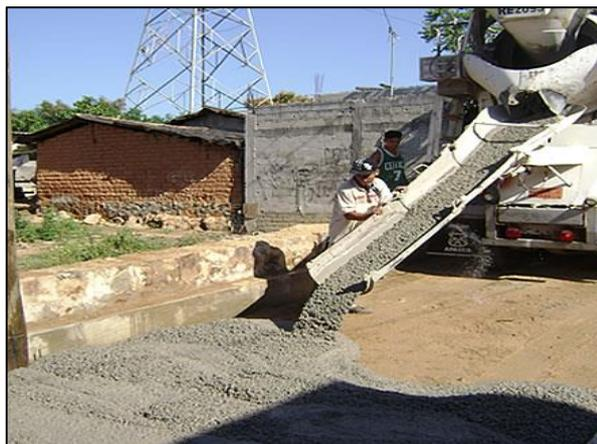
**Figura 21.** Concreto pre mezclado
