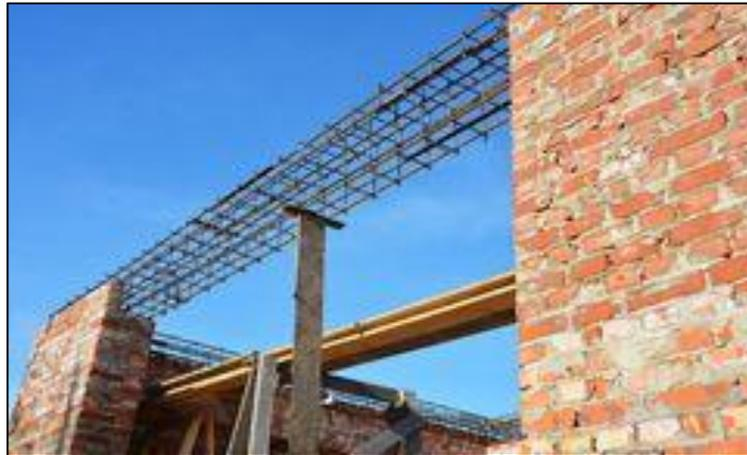
**Figura 13.** Vigas de concreto armado
