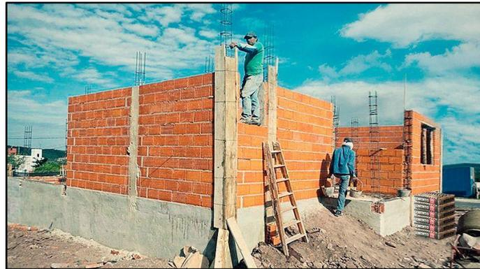
*Figura 4.* Albañilería confinada
