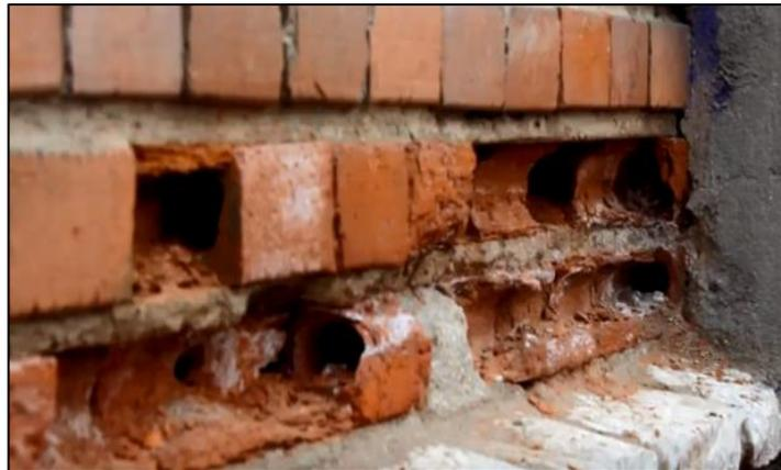
***Figura 22. Erosión Física***
