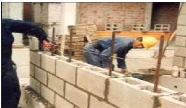
**Figura 5.** Albañilería Armada
