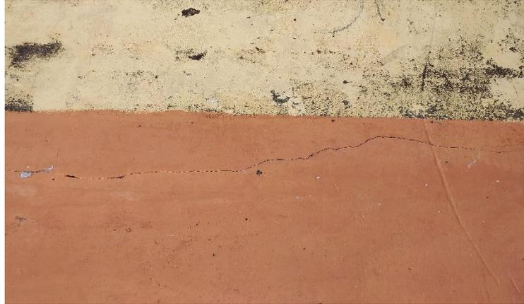
**Imagen 07.** Fisura en elemento de concreto.
