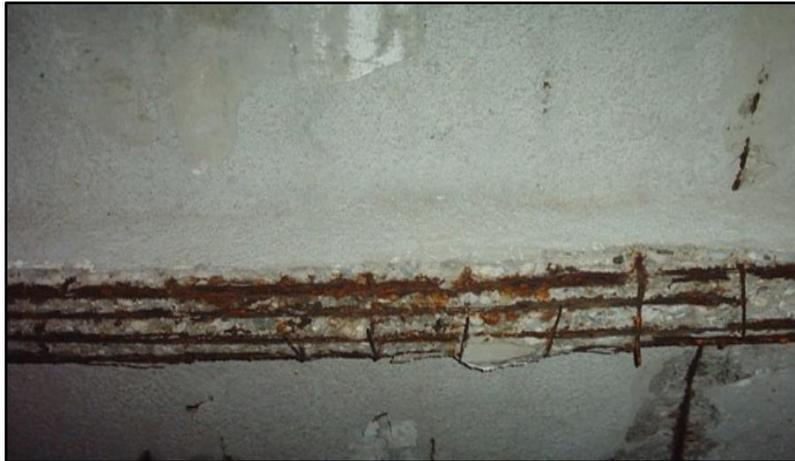
**Imagen 10.** Corrosión en la armadura de acero.
