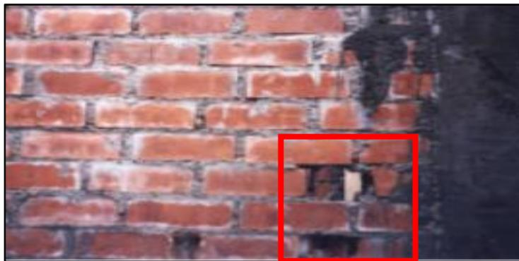
**Imagen 08.** Desintegración en muro de albañilería.
