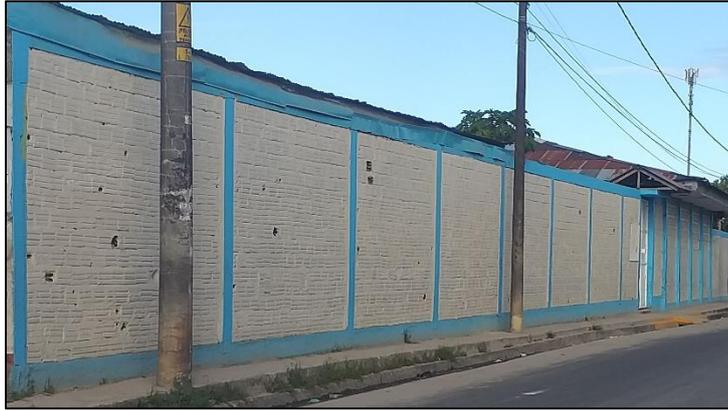
**Imagen 03.** Muro de albañilería confinada.
