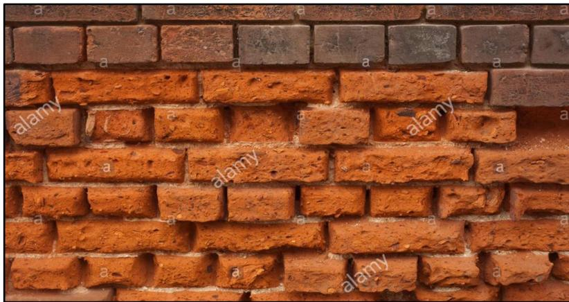
**Imagen 05.** Erosión en muro de albañilería.
