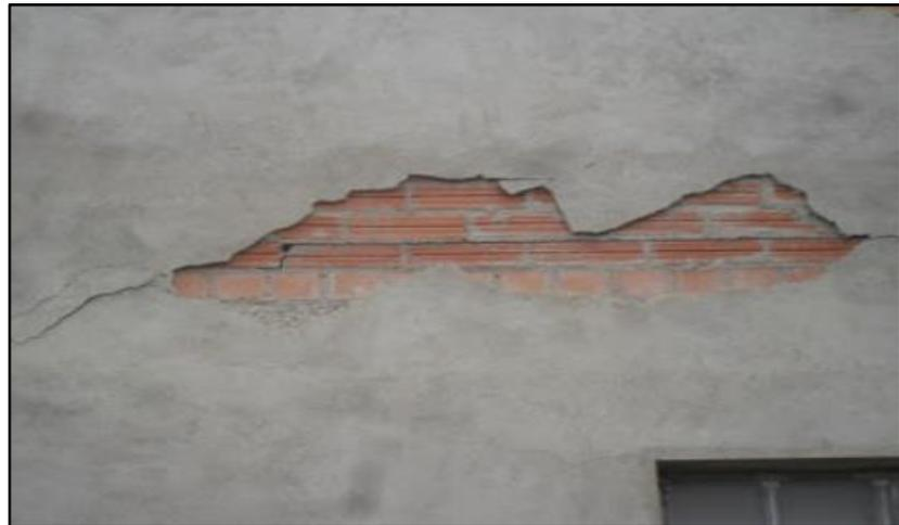
**Imagen 09.** Desprendimiento en muro de albañilería.
