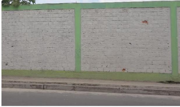
**Imagen 04.** Muro de albañilería confinada.
