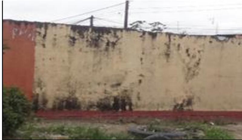
**Imagen 11.** Moho en los muros de albañilería.
