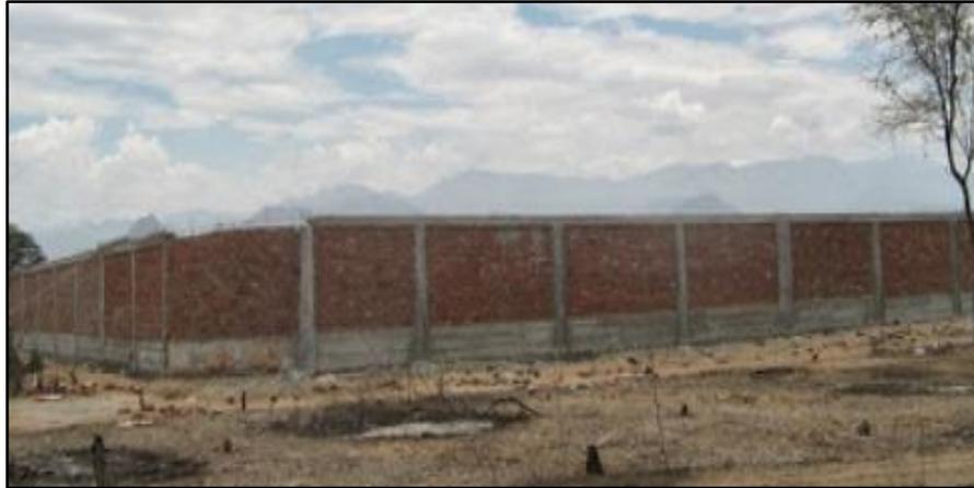
**Imagen 02.** Cerco perimétrico de albañilería confinada.
