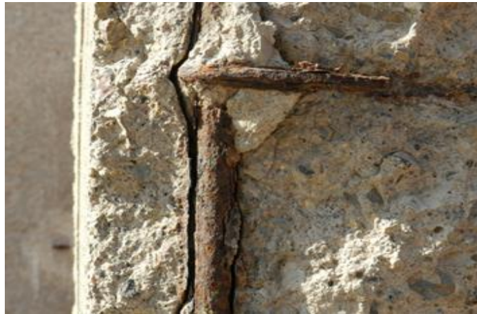
Fig. 17 Corrosión
