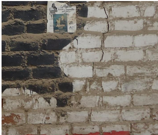
Fig. 12 Fisura
