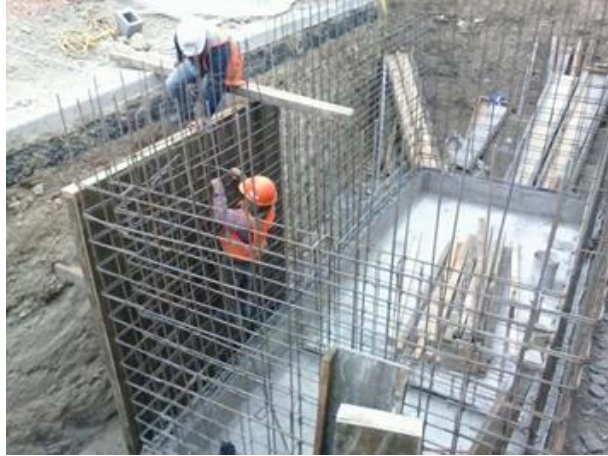
Fig. 4 Muros armados
