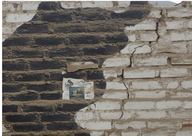
Fig. 9 Lesiones mecánicas Fuente: Elaboración propia (2019)
