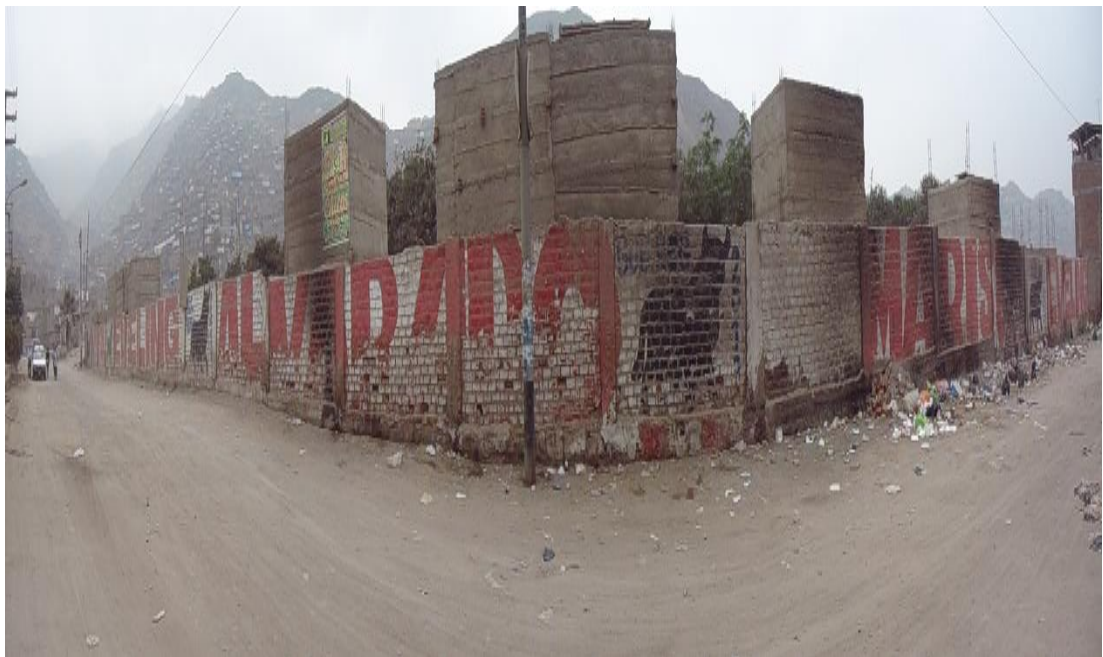
Foto 2 Vista panorámica del cerco lado Noreste (FE)
