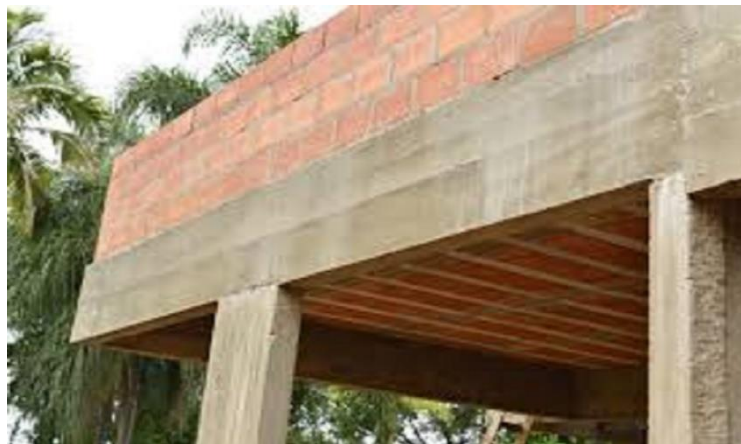
Figura 04: Imagen de viga
