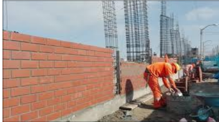
Figura 05: Imagen de cerco perimétrico.
