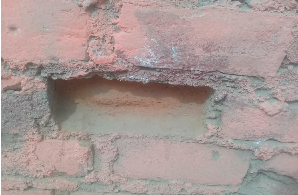
Fotografía 5: Muro afectada por erosión física en la Unidad de Muestra 6
