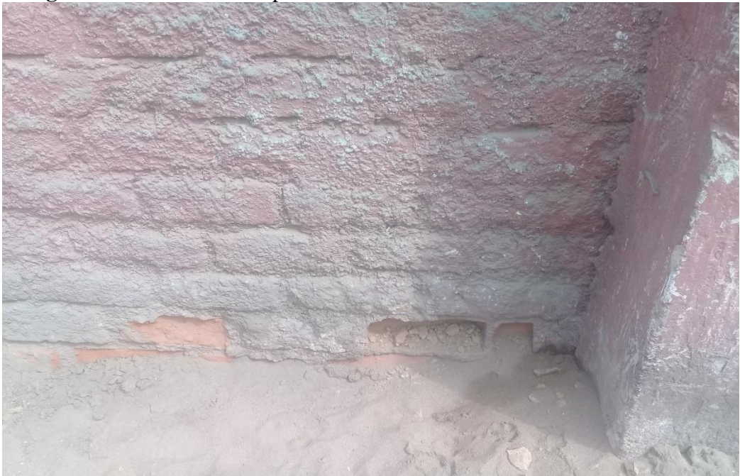
Fotografía 5: Muro afectada por erosión física en la Unidad de Muestra 6
