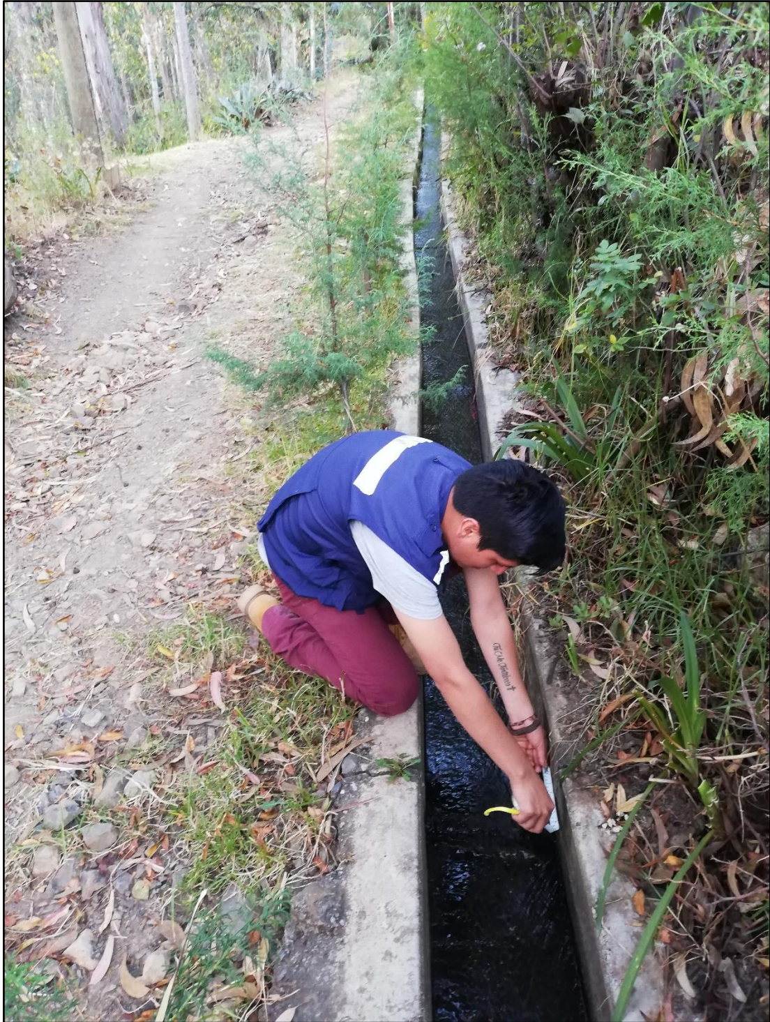
Fotografía 09: En esta fotografía se puede apreciar la toma de medidas de los sellos de junta del canal de riego Monterrey que tienen una medida de 3 cm de ancho y 5 cm de profundidad.
