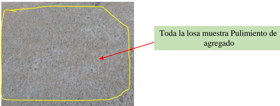
Figura 147:daño de pulimiento de agregado
