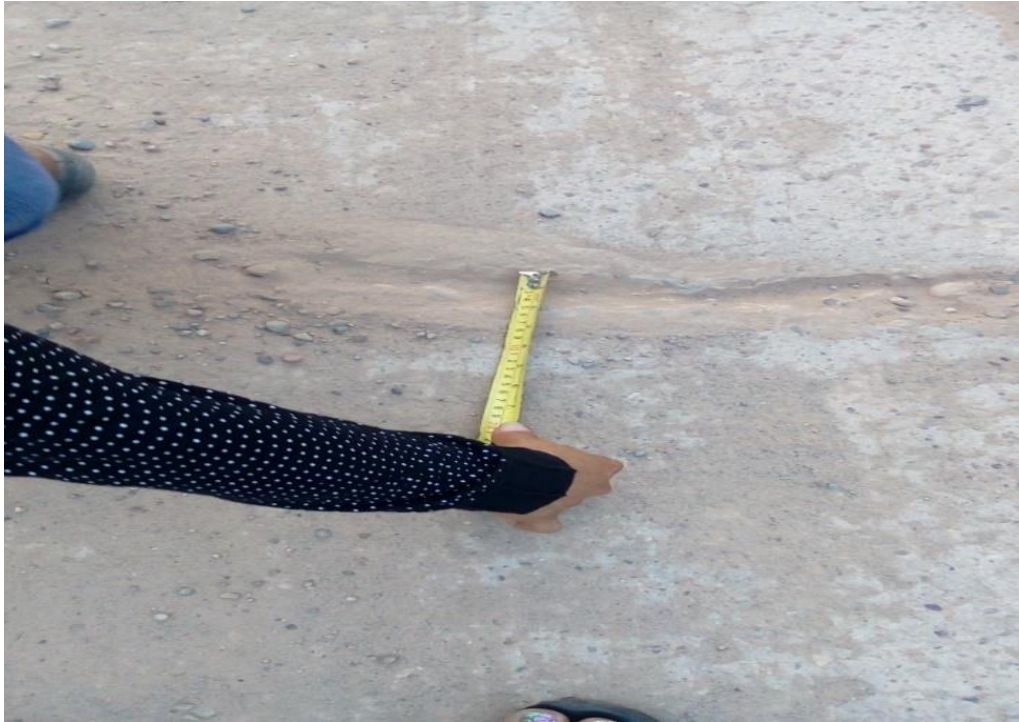
Figura 126: vista de grieta lineal
