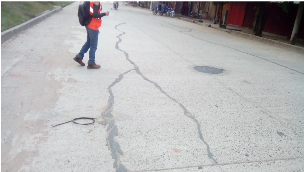
Figura 126: vista de grieta lineal
