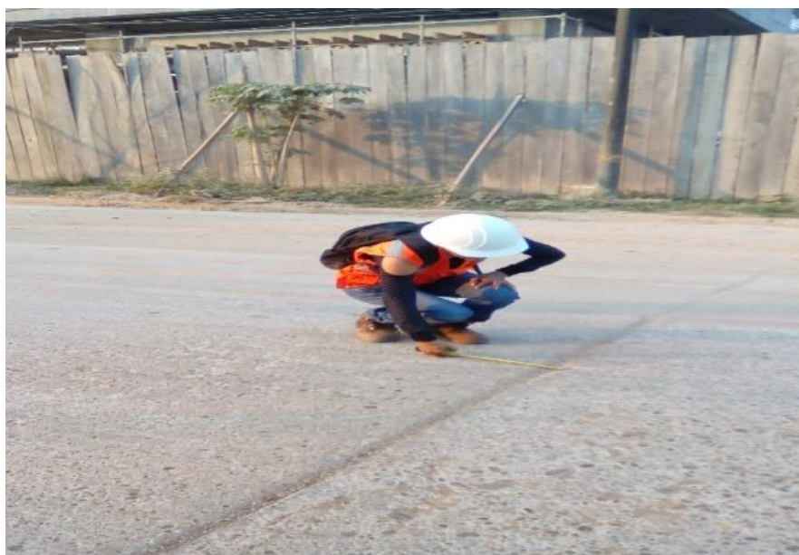
Figura 18: Sello de junta de baja severidad.
