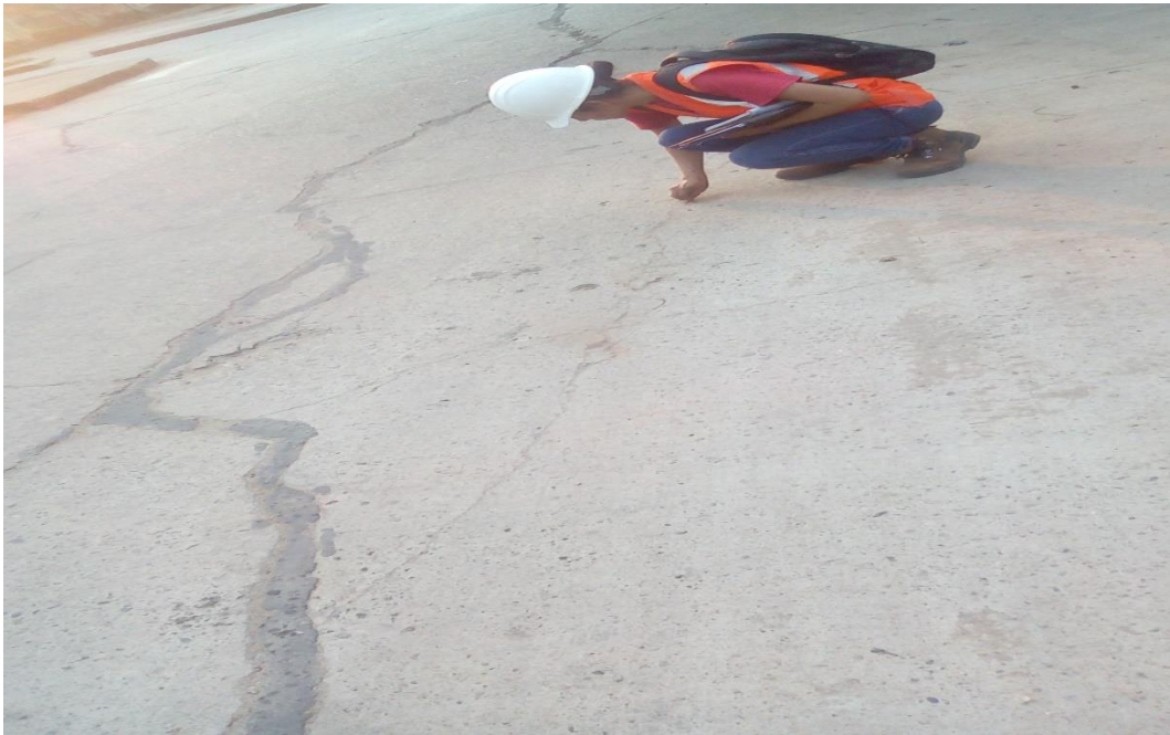
figura 130: grietas lineales
