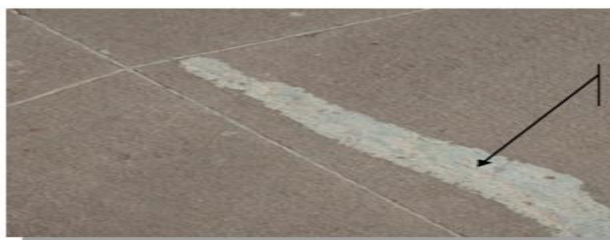
Fisura sellada con material mastic asfaltico
