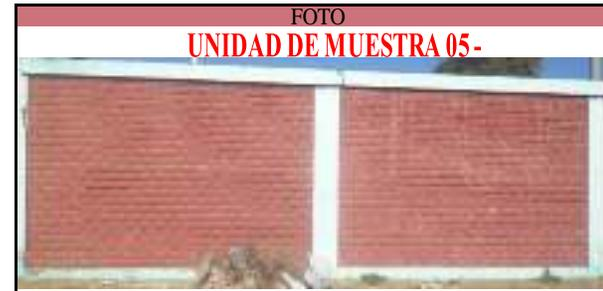
**DESCRIPCION DE LA UNIDAD DE MUESTRA:** La unidad de muestra consta de 2 paños, con medidas de 4.12m . Dicha muestra consta de 3 columnas, 2 vigas, 2 muros de ladrillo y 2 sobrecimientos. La muestra se ubica en la parte exterior del coliseo.
