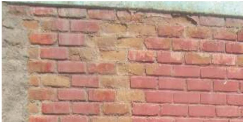
**Gráfico 16:** Erosión en muros.
