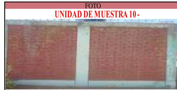
DESCRIPCIÓN DE LA UNIDAD DE MUESTRA: La unidad de muestra consta de 2 paños, con medidas de 1.88m . Dicha muestra consta de 2 columnas, 2 vigas, 2 muros de ladrillo y 2 sobrecimientos. La muestra se ubica en la parte exterior del coliseo.
