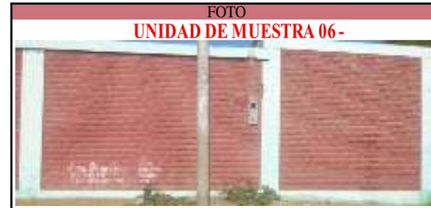
**DESCRIPCIÓN DE LA UNIDAD DE MUESTRA:** La unidad de muestra consta de 2 paños, con medidas variables de 3.62m y 4.30m. Dicha muestra consta de 3 columnas, 2 vigas, 2 muros de ladrillo y 2 sobrecimientos. La muestra se ubica en la parte exterior del coliseo.
