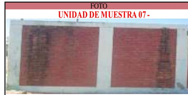
DESCRIPCIÓN DE LA UNIDAD DE MUESTRA: La unidad de muestra consta de 2 paños, con medidas de 1.88m . Dicha muestra consta de 3 columnas, 2 vigas, 2 muros de ladrillo y 2 sobrecimientos. La muestra se ubica en la parte exterior del coliseo.
