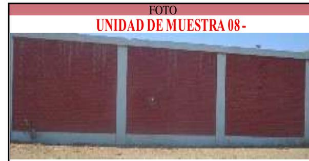
DESCRIPCIÓN DE LA UNIDAD DE MUESTRA: La unidad de muestra consta de 3paños, con medidas variables de 4.40 m ,4.06m y 4.07m. Dicha muestra consta de 3 columnas, 3 vigas, 3 muros de ladrillo y 3 sobrecimientos. La muestra se ubica en la parte exterior del coliseo.
