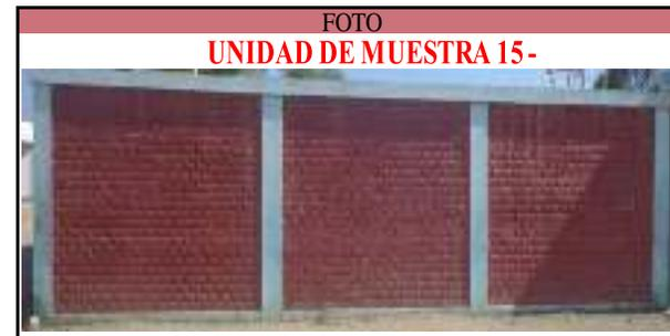
DESCRIPCION DE LA UNIDAD DE MUESTRA: La unidad de muestra consta de 3 paños, con medidas variables de 4.05 y 4.06m . Dicha muestra consta de 4 columnas, 3 vigas, 3 muros de ladrillo y 3 sobrecimientos. La muestra se ubica en la parte exterior del coliseo.
