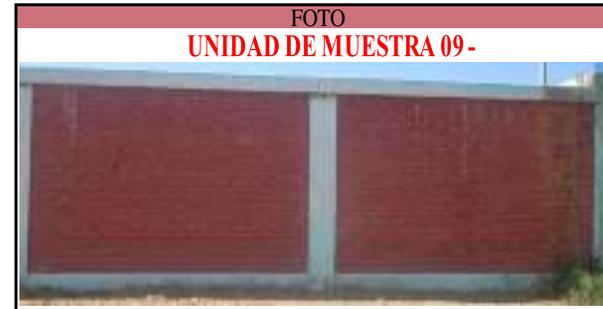
DESCRIPCIÓN DE LA UNIDAD DE MUESTRA: La unidad de muestra consta de 2 paños, con medidas de 4.06m . Dicha muestra consta de 3 columnas, 2 vigas, 2 muros de ladrillo y 2 sobrecimientos. La muestra se ubica en la parte exterior del coliseo.
