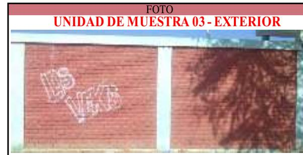
DESCRIPCIÓN DE LA UNIDAD DE MUESTRA: La unidad de muestra consta de 2 paños, con medidas de 4.12m. Dicha muestra consta de 3 columnas, 2 vigas, 2 muros de ladrillo y 2 sobrecimientos. Lamuestra se ubica en la parte exterior del coliseo.
