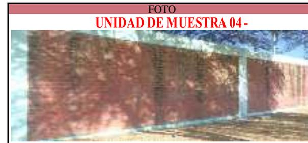
**DESCRIPCIÓN DE LA UNIDAD DE MUESTRA:** La unidad de muestra consta de 2 paños, con medidas de 4.12m y Dicha muestra consta de 3 columnas, 2 vigas, 2 muros de ladrillo y 2 sobrecimientos. La muestra se ubica en la parte exterior del coliseo.
