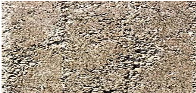
**Gráfico 11:** Picaduras o Cavitación en estructuras de concreto.
