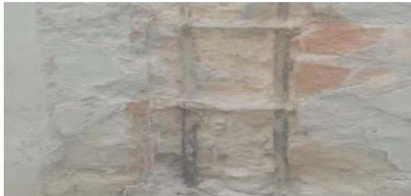
**Gráfico 10:** Corrosión en columnas.
