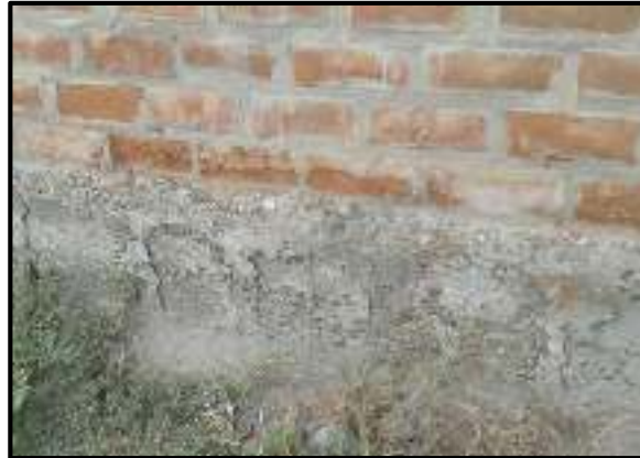
Gráfico 10: Desintegración del sobrecimiento.
