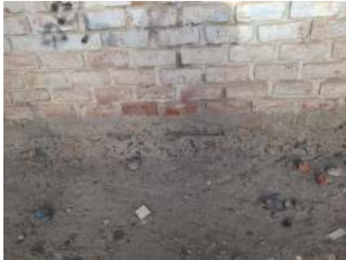
Gráfico 115: Erosión en el sobrecimiento.
