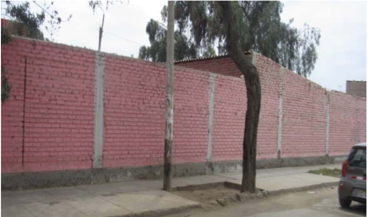
Fotografía 15: Vista panorámica de Unidad de Muestra N° 14, se logra apreciar la presencia de picadura y eflorescencia Fuente (I.E. MANUEL A. MESONES MURO)
