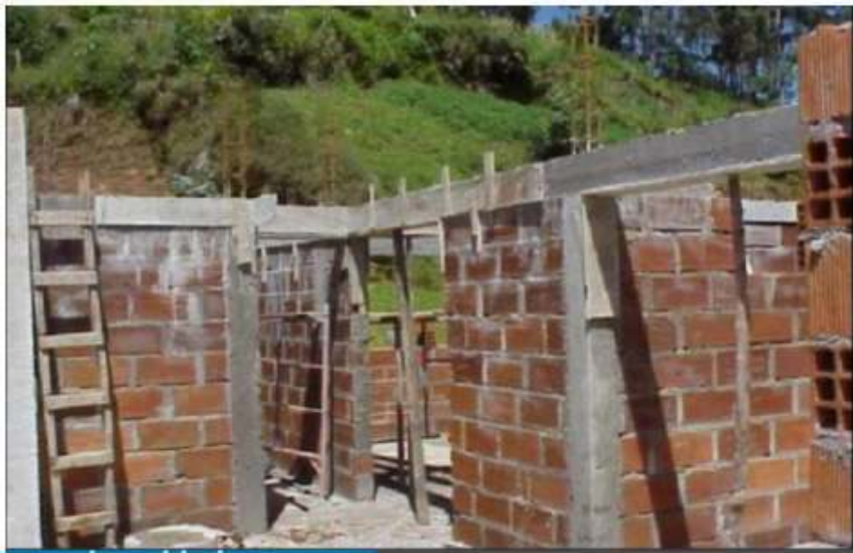
Gráfico 01. Imagen de estructura de albañilería confinada
