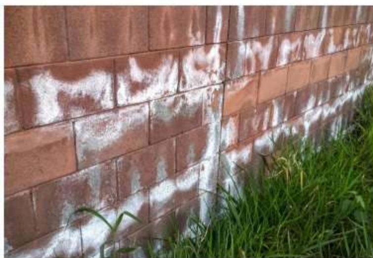
Gráfico 08. Eflorescencia en las paredes.
