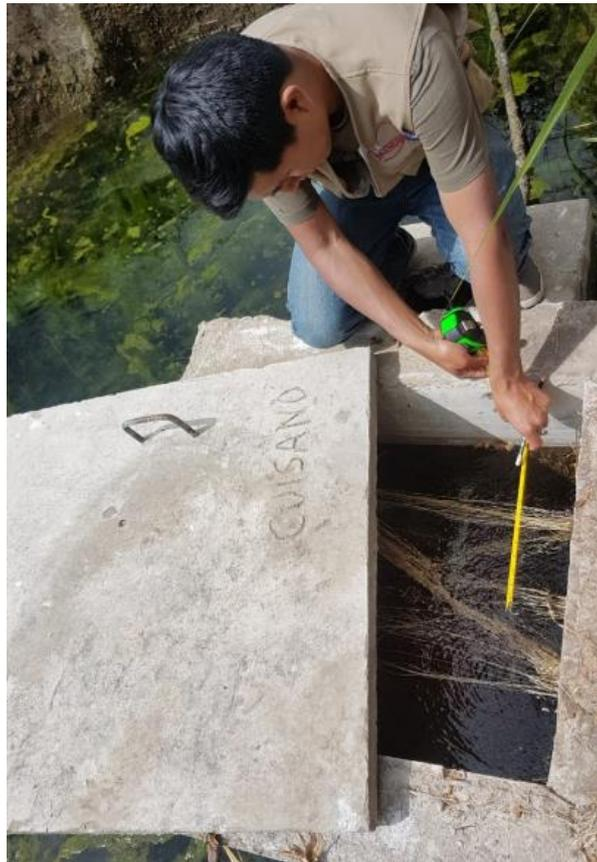
**Imagen 2:** Podemos apreciar la cámara captación tipo manantial de ladera el cual se encuentra en mal estado debido al paso del tiempo.
