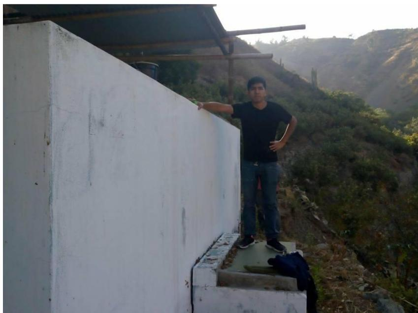
**Imagen 6:** Se observa el reservorio de agua potable rectangular. La estructura no cuenta con un cerco perimétrico.
