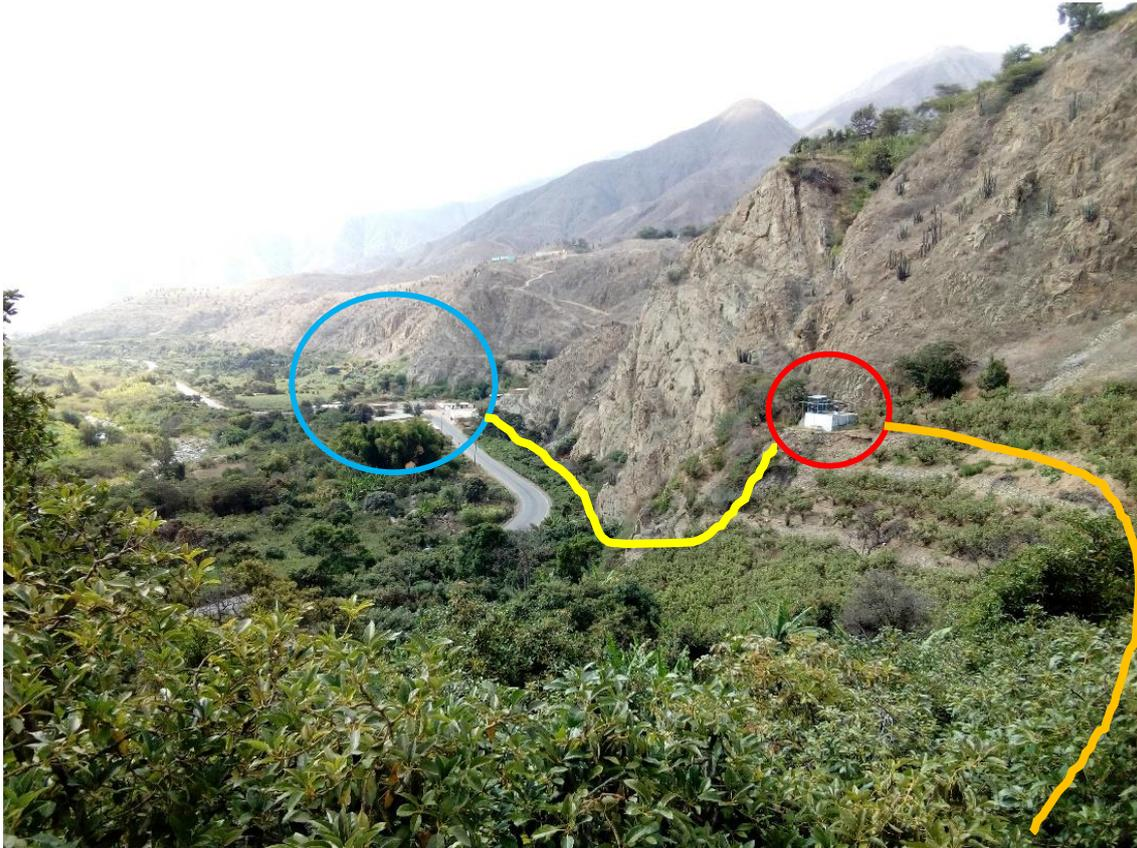
**Imagen 14:** Podemos apreciar el área donde se encuentra la línea de conducción (línea naranja), el reservorio (círculo rojo), la línea de aducción (línea amarilla) y el caserío Racrao bajo (círculo azul) vistas desde la captación.
