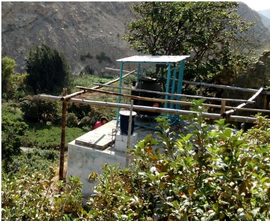
**Imagen 8:** Se observa en la parte superior del reservorio un tanque clorador de 600 litros.
