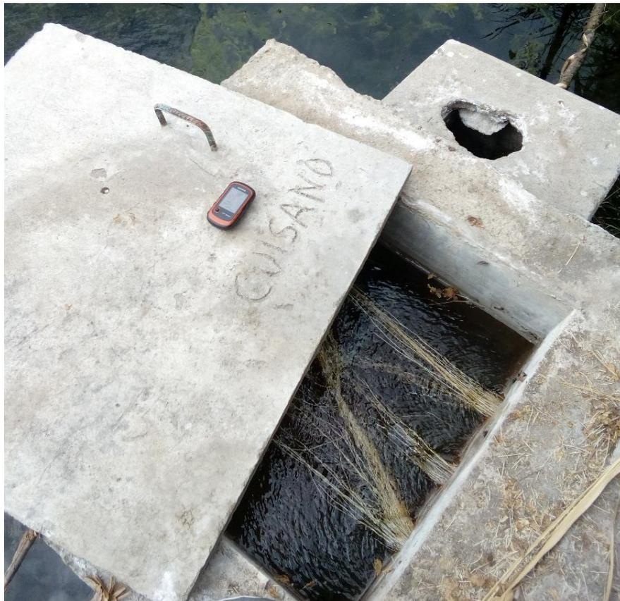
**Imagen 4:** Podemos apreciar la cámara seca de la captación, el cual en su tapa de concreto presenta un orificio.
