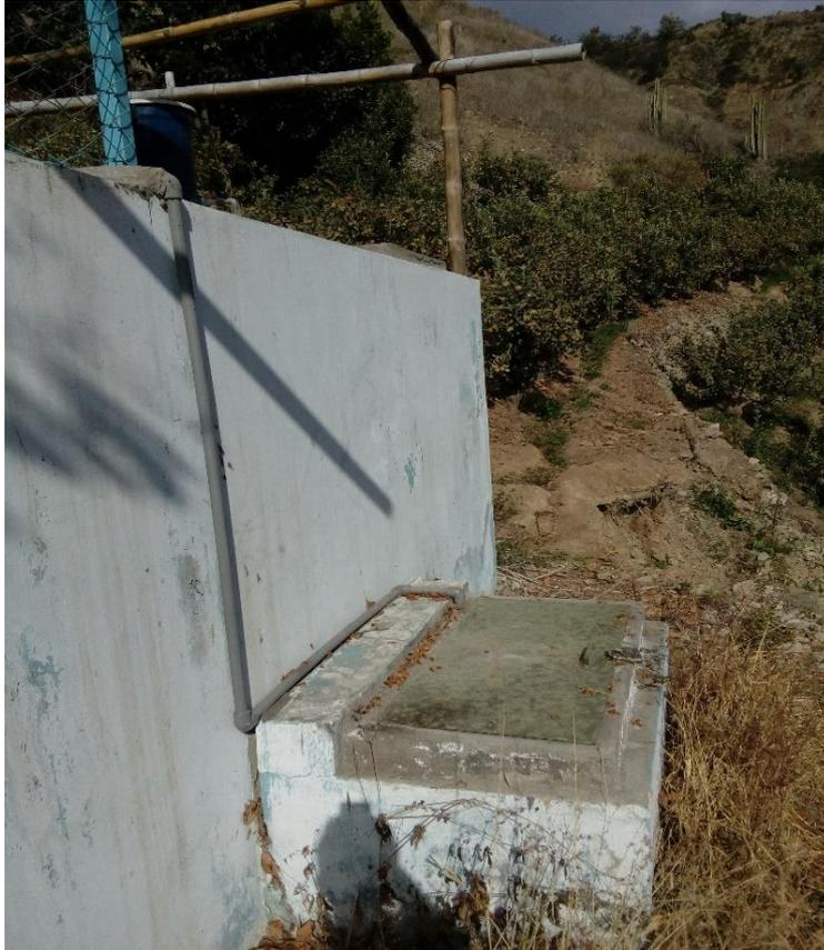
**Imagen 7:** Se observa la cámara seca del reservorio y la tubería de rebose expuesta.
