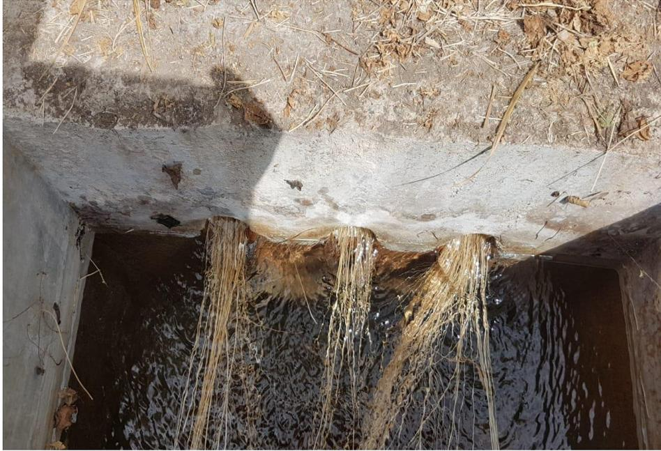
**Imagen 3:** Podemos apreciar la cámara húmeda de la captación, el cual presenta segregación del concreto en sus lados y bordes.
