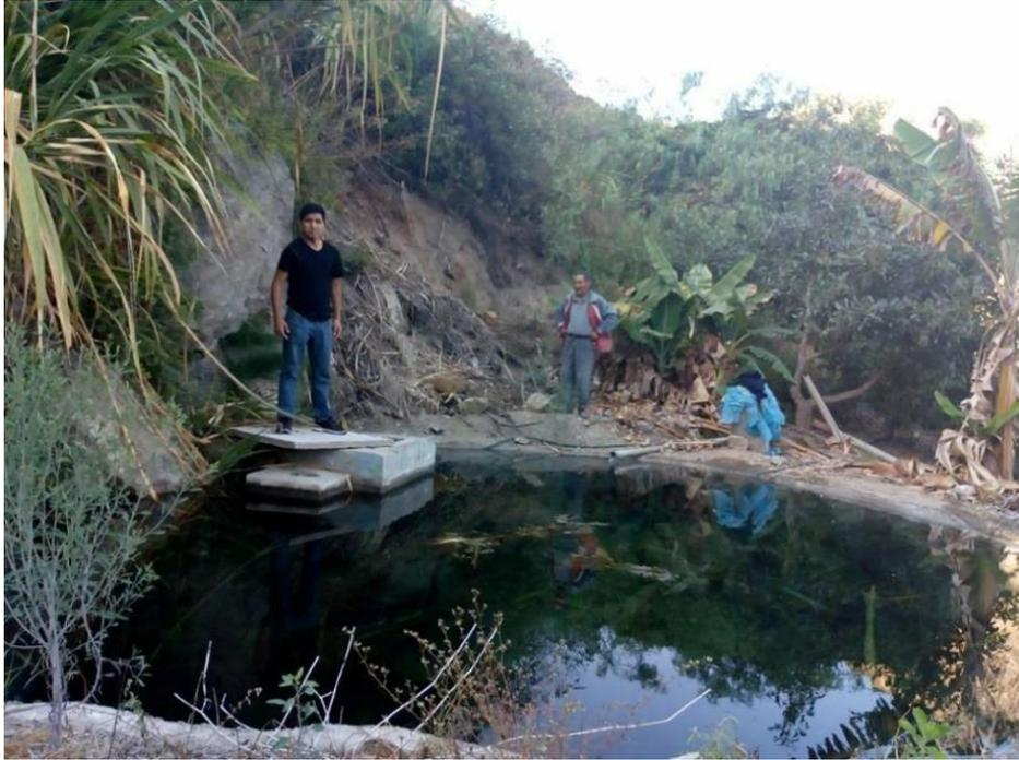
**Imagen 1:** Se observa la captación tipo ladera. La estructura no cuenta con un cerco perimétrico.
