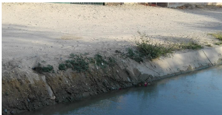
Gráfico 10: Sedimentación en estructura de concreto.
