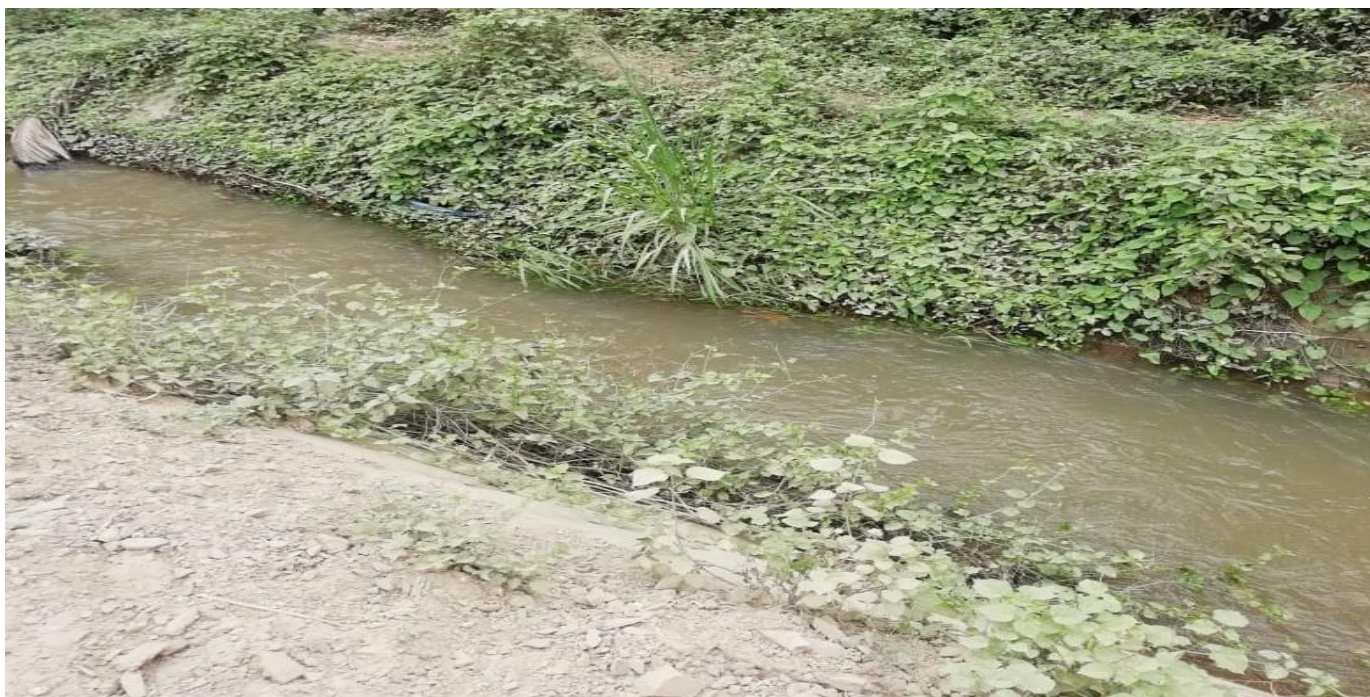
Gráfico 85: Presencia de vegetación en la parte lateral del canal.
