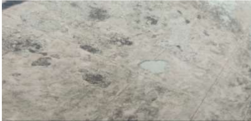
Figura 20: Desintegración – Reservorio Apoyado R1
