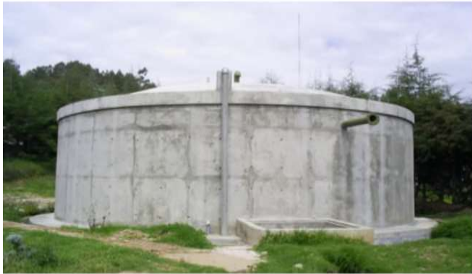
Figura 7: Reservorio superficiales de concreto armado.
