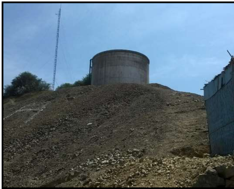
Figura2: Vista Panorámica del Reservoirio R1
