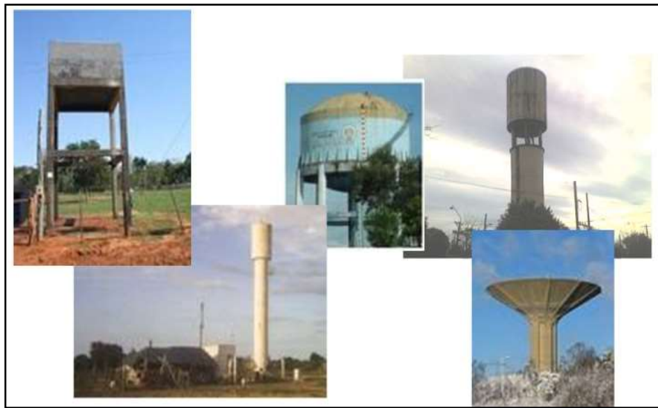
Figura 6: Reservorio Elevados de Concreto Armado.
