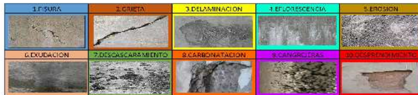
CUADRO DE PATOLOGIAS EN EL RESERVORIO APOYADO
