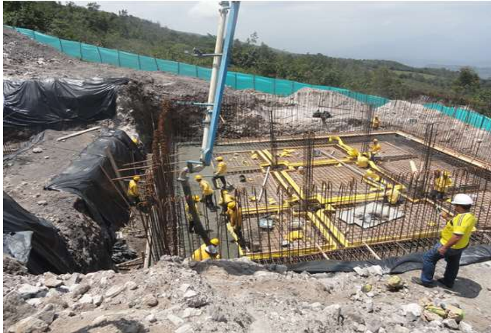
Figura 4: Reservorio Enterrado de Concreto Armado.
