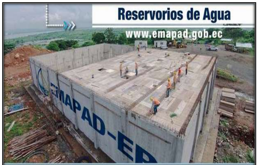
Figura 3: Ejemplo de Reservorio de Concreto Armado. Fuente: Web Emapad-Ep. Reservorios de agua. (2018) 11
