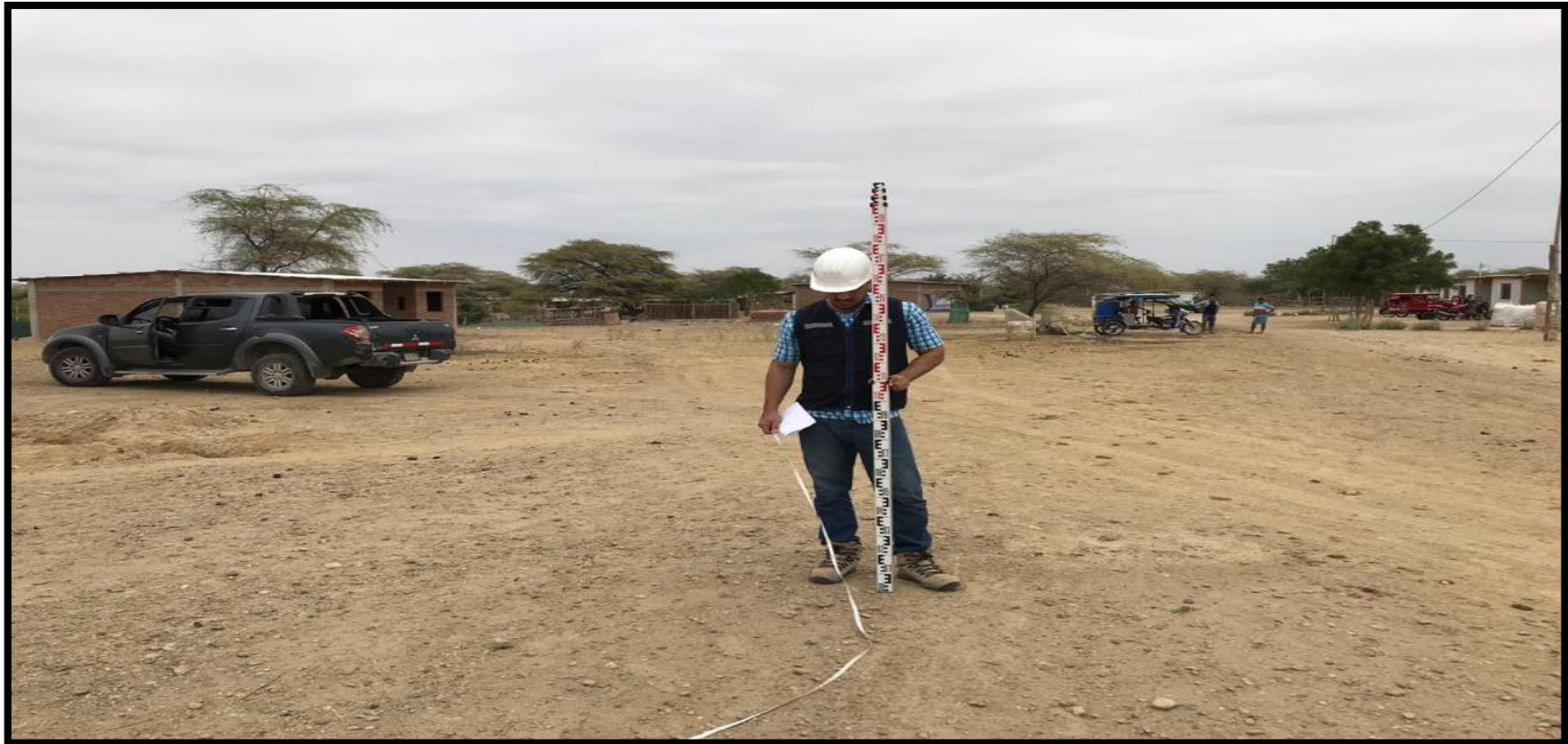
Gráfico 23: Con mira y wincha a cada 20m para colocación de puntos.
