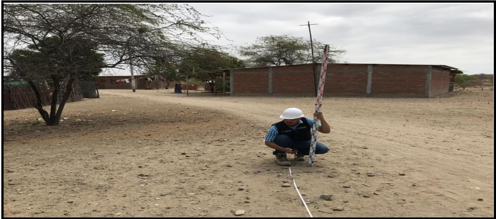
Gráfico 21: Colocación de puntos topográficos
