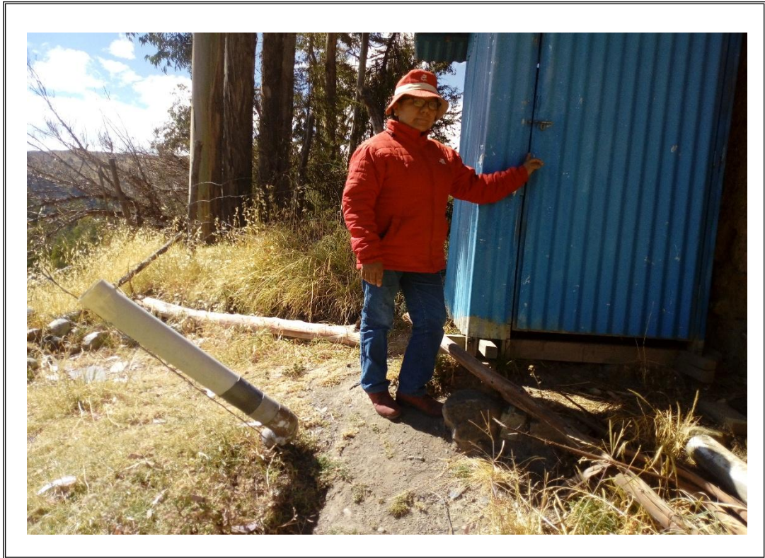
Fotografía N° 11: Letrina de hoyo seco sin Chimenea.
