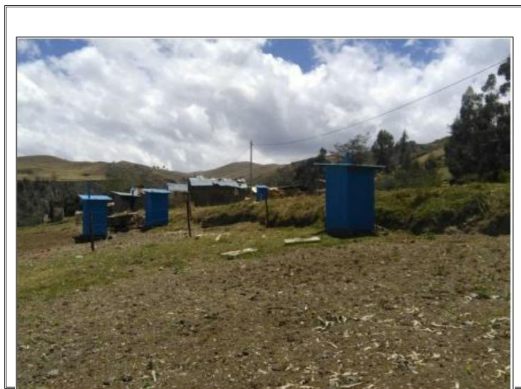
Fotografía N° 10: Sistema de eliminación de excretas en el barrio de Santa Rosa- Yancosheca
