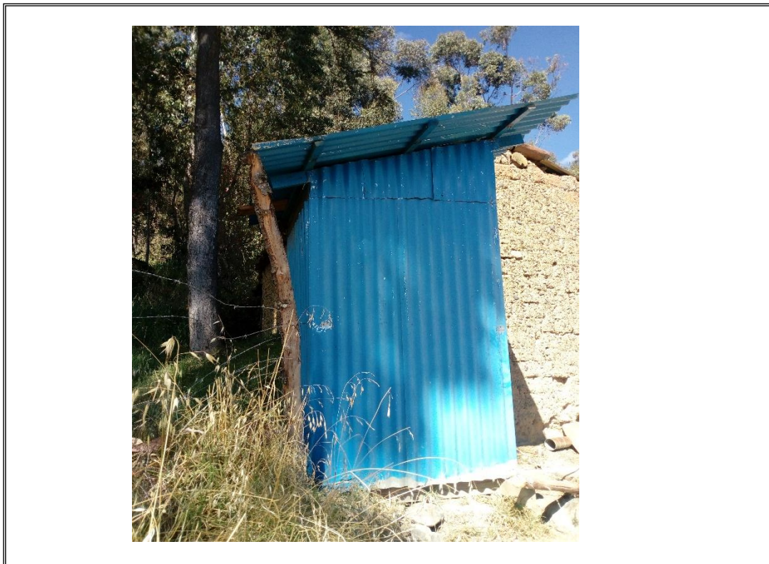
Fotografía N° 12: Letrina sin Chimenea
