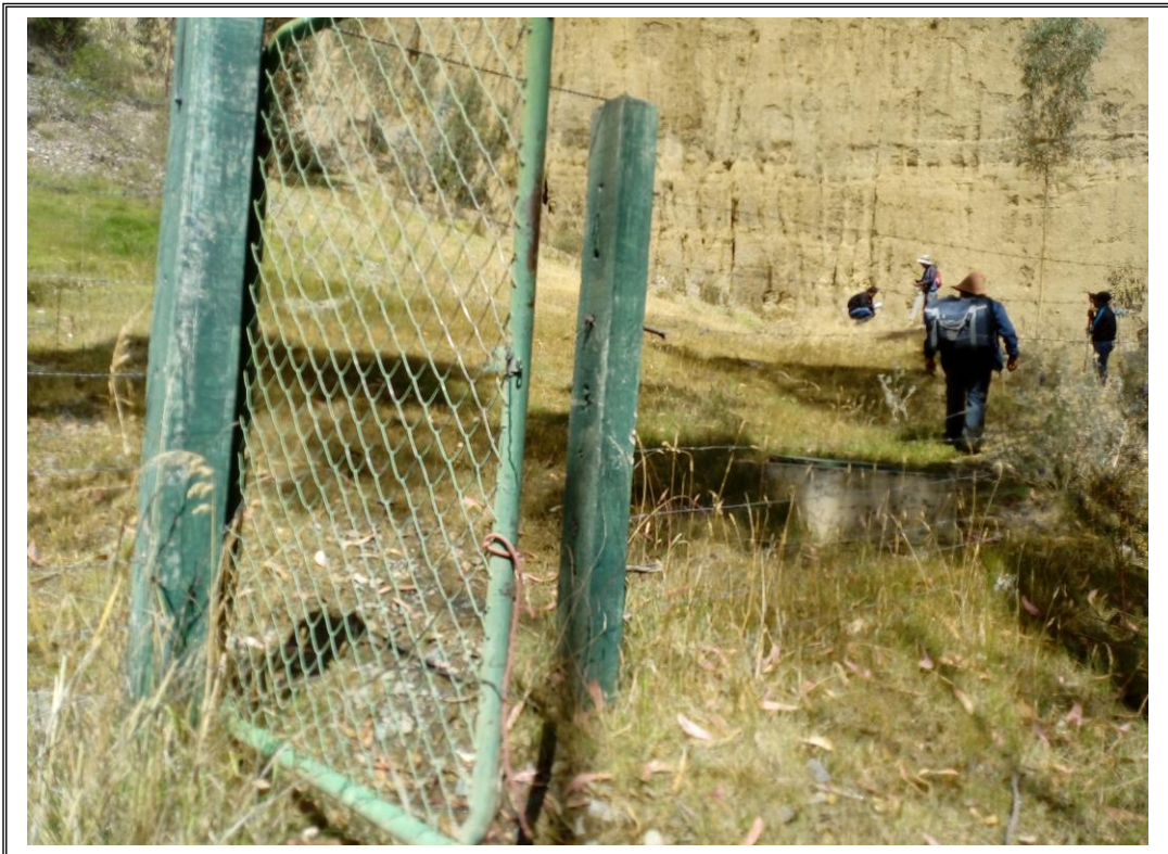
Fotografía N° 02: Estado actual de la captación de agua Barrio de Santa Rosa - Yancoshca
