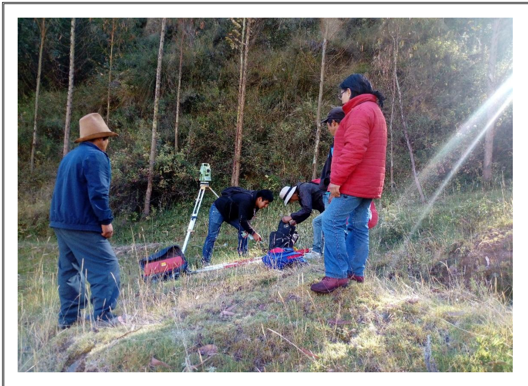
Fotografía N° 14: Levantamiento Topográfico recorrido por el sistema de agua del barrio de Santa Rosa – Yancoshca.
