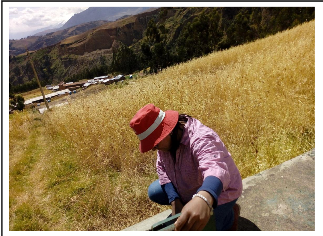
Fotografía N° 07; Inspección de la parte interna del reservorio
