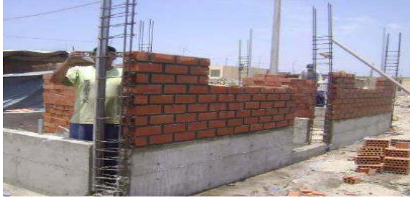
Figura 1: Muro de Albañilería Confinada
