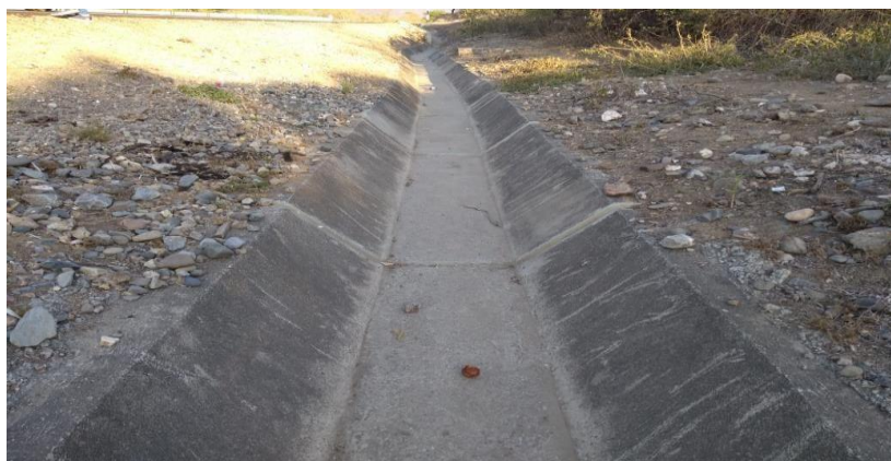
Gráfico 3. Canal de concreto
