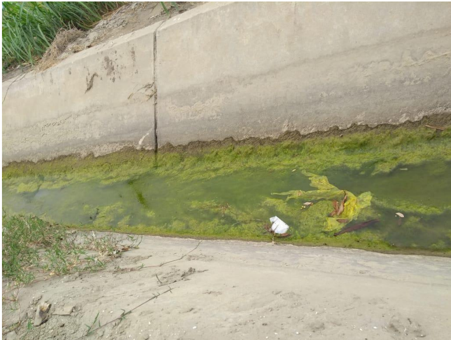
Gráfico 73. Sedimentación de sólidos en el canal
