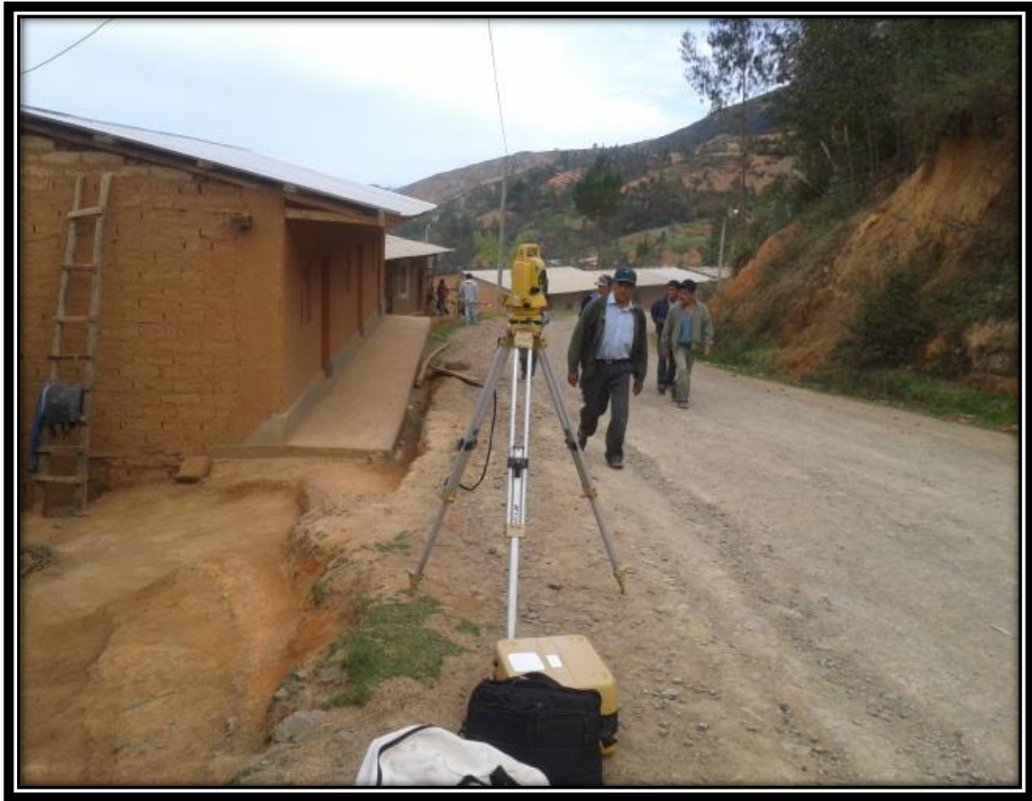
INSTALACIÓN DE EQUIPO TOPOGRÁFICO
