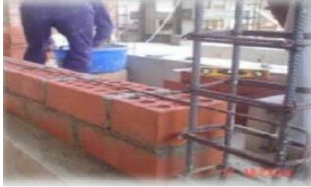
**Figura 3.** Albañilería confinada
