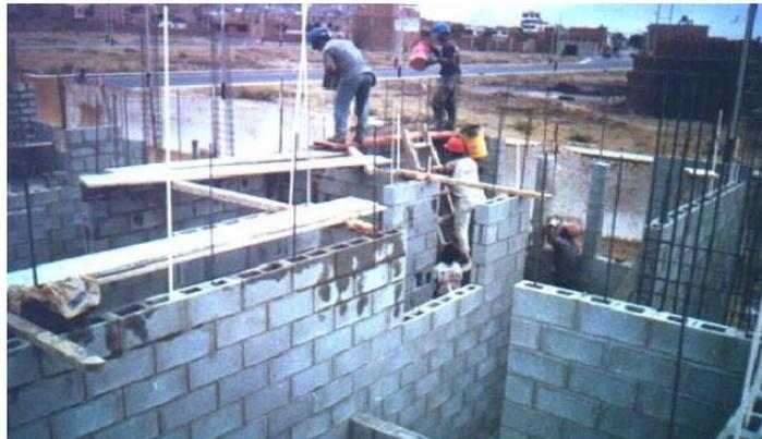
**Figura 4.** Albañilería Armada
