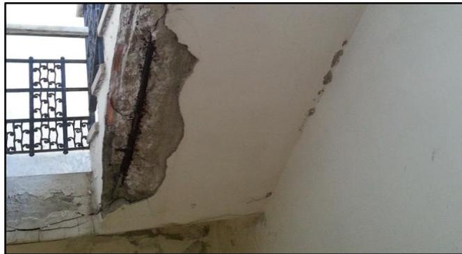
**Figura 14.** Corrosión en losa aligerada
