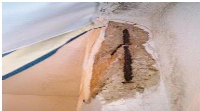
**Figura 17.** Corrosión en Columna
