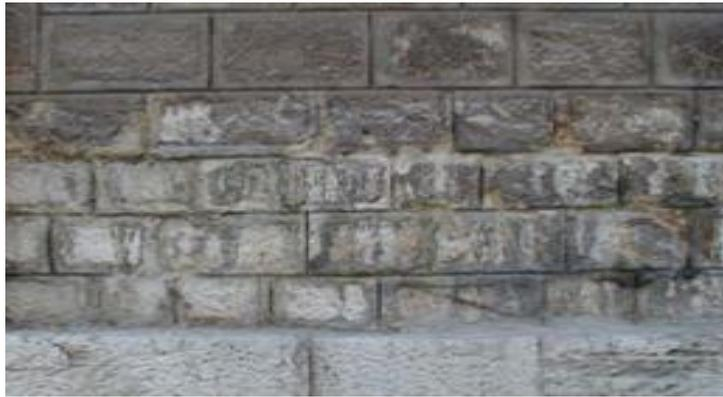
**Figura 16.** Eflorescencia en muro
