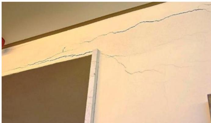
**Figura 18.** Fisura en revoque
