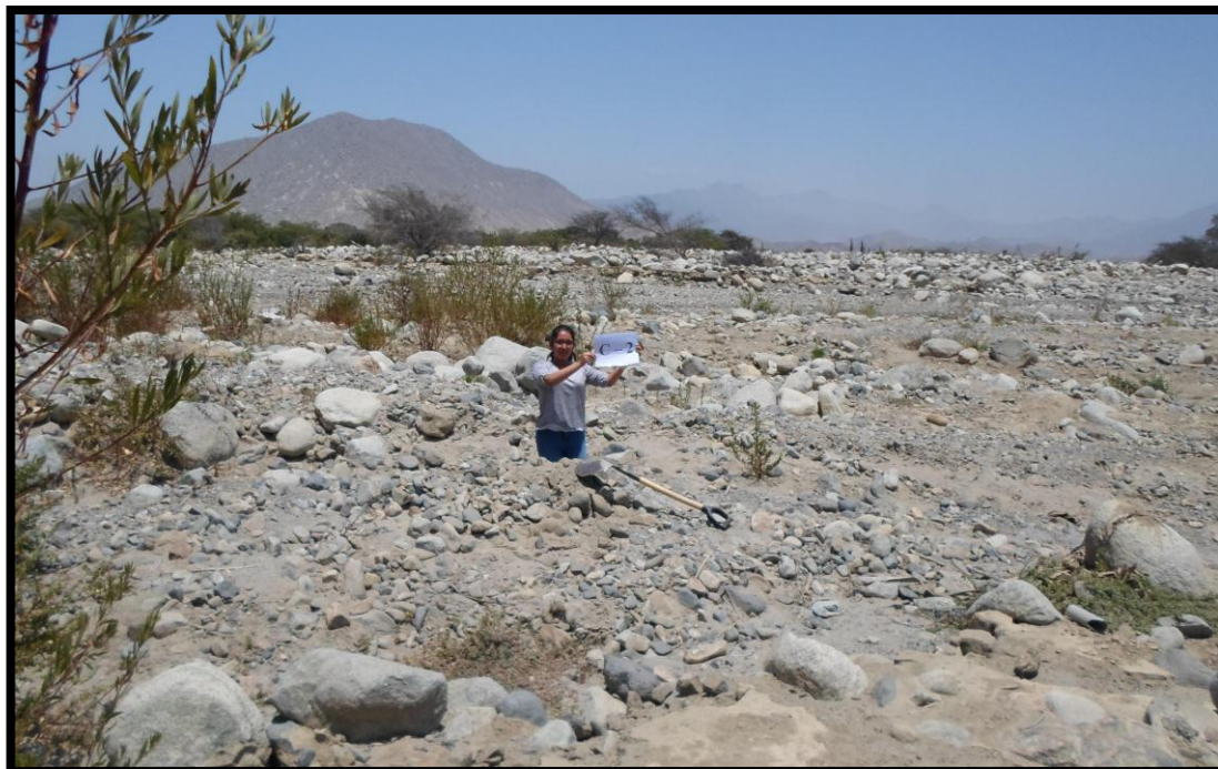
Imagen 15. Elaboración de calicata (C – 2), en el área destinada de la PTAR del diseño de alcantarillado sanitario para el caserío de Vichamarca.
