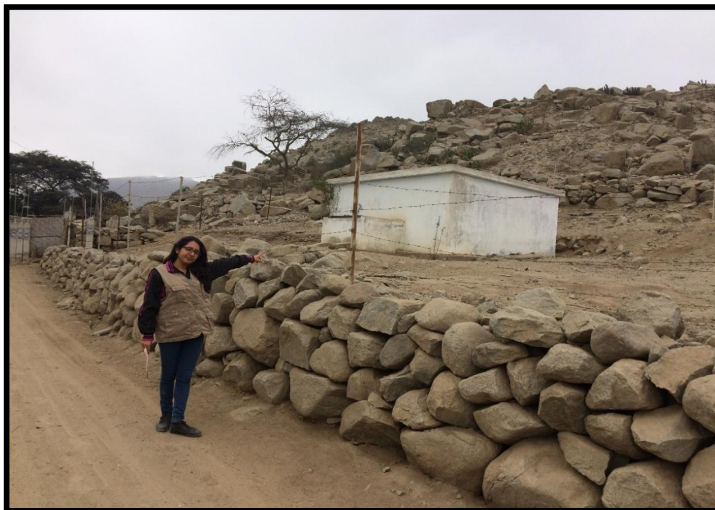
Imagen 17. Reservorio de agua en funcionamiento del caserío de Vichamarca.
