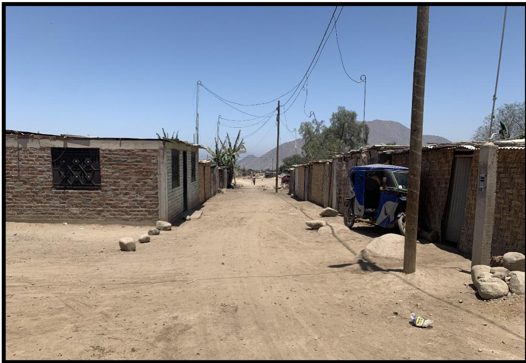
Imagen 5. Área destinada para el inicio de la red de alcantarillado, Buzón N° 5.
