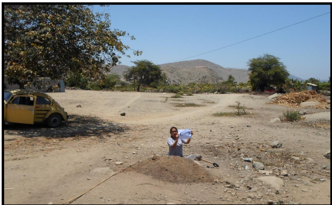
Imagen 16. Elaboración de calicata (C – 3), en el área destinada del Colector del diseño de alcantarillado sanitario para el caserío de Vichamarca.
