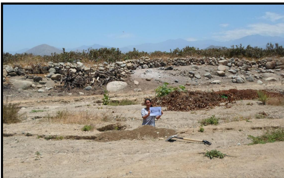
Imagen 14. Elaboración de calicata (C – 1), en el área destinada para el emisor del diseño de alcantarillado sanitario para el caserío de Vichamarca.
