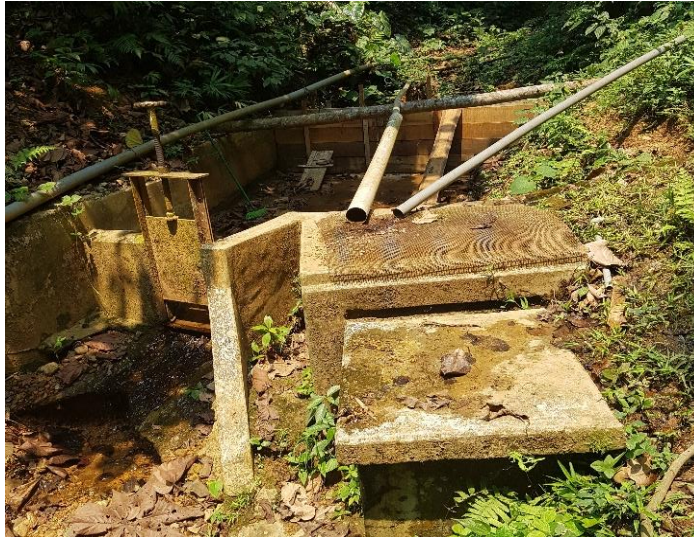
Figura 21: Captación actual de San Isidro
