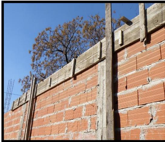
**Gráfico 3.** Construcción de viga de concreto armado.
