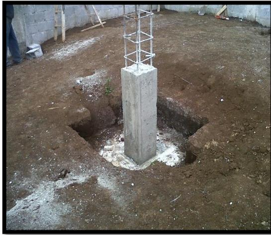
**Gráfico 2.** Columna de concreto armado
