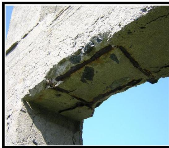
**Gráfico 12.** Corrosión del armado de una viga.
