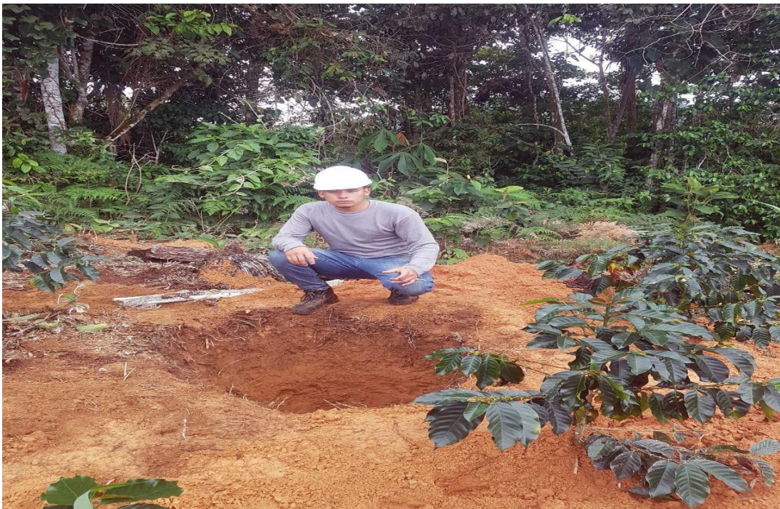
Fotografía 02: Final de excavación a 1.50 mts de profundidad para el análisis de suelo de reservorio.
