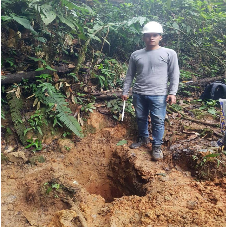
Fotografía 04: Final de excavación a 1.50 mts de profundidad para el análisis de suelo de captación.
