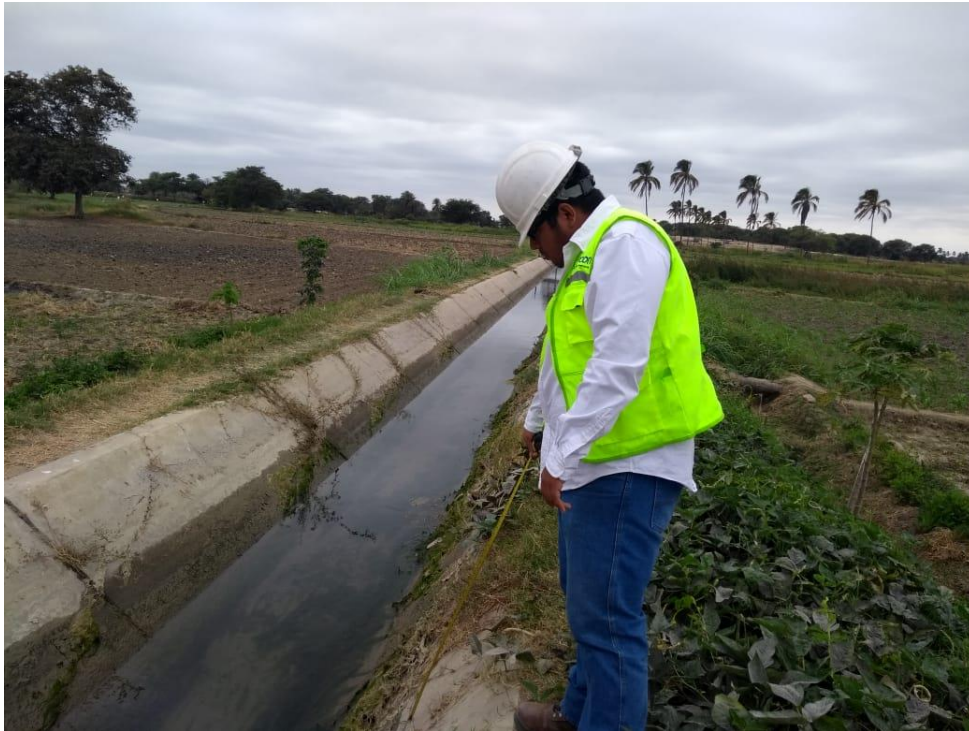
Gráfico 94: Determinación de la vegetación en la losa lateral del canal
