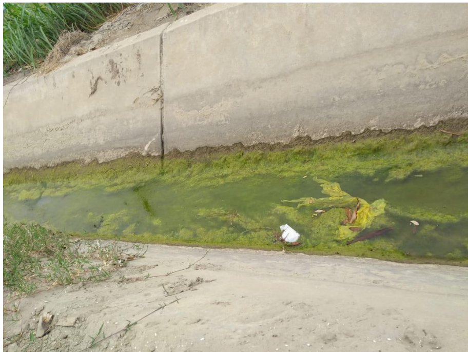
Gráfico 90: Sedimentación de sólidos en el canal
