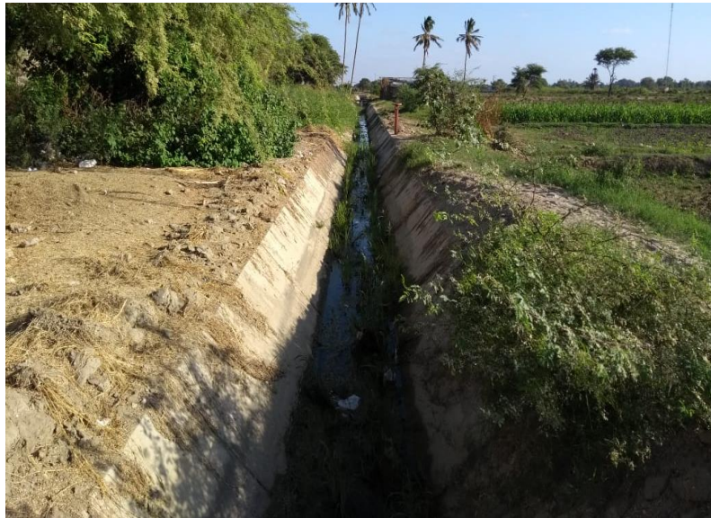
Gráfico 12: Vegetación en canal de concreto.
