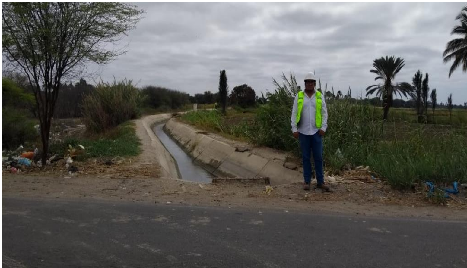
Gráfico 86: Vista exterior del canal lateral Santa Lucia.
