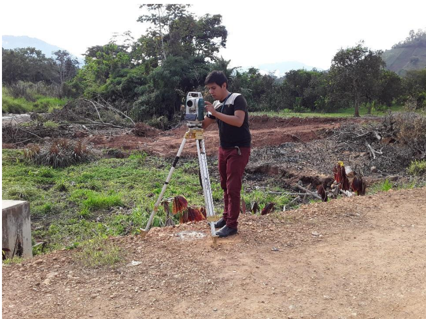
Ilustración 7. Levantamiento topográfico de línea de aducción.
