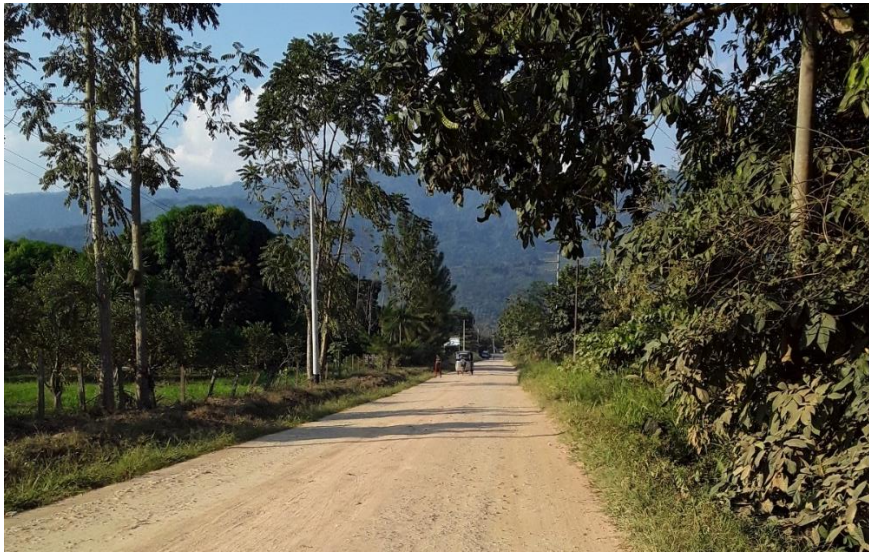
Ilustración 6. Carretera de acceso a la localidad los libertadores.
