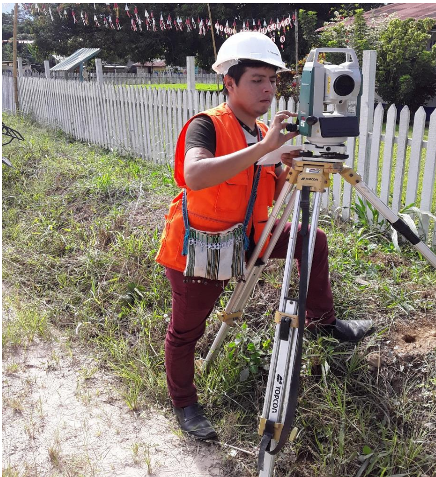
Ilustración 9. Levantamiento topográfico red de distribución.
