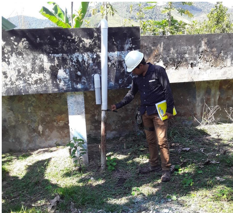
Ilustración 17. Inspección de Filtro Lento – tubería de ingreso. Fuente: elaboración propia.
