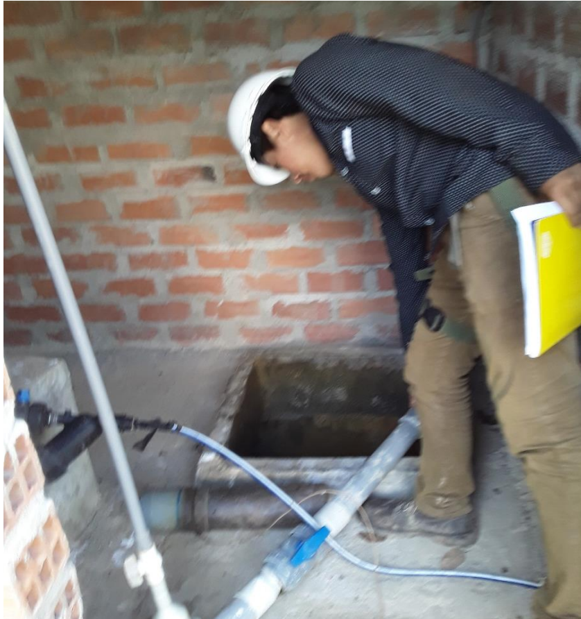
Ilustración 12. Inspección de dosificador existente.
