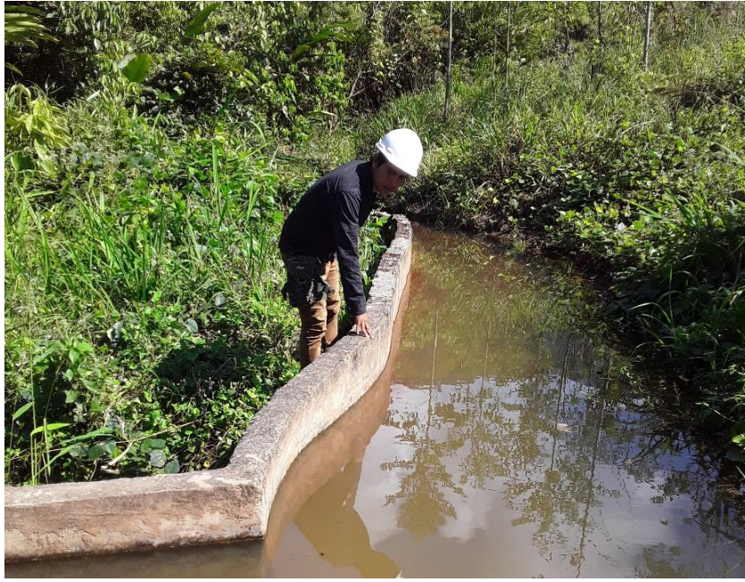
Ilustración 16. Inspección de captación existente – tomas laterales. Fuente: elaboración propia.
