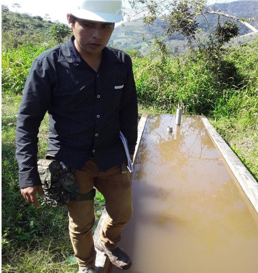
Ilustración 10. Inspección del sedimentador existente.
