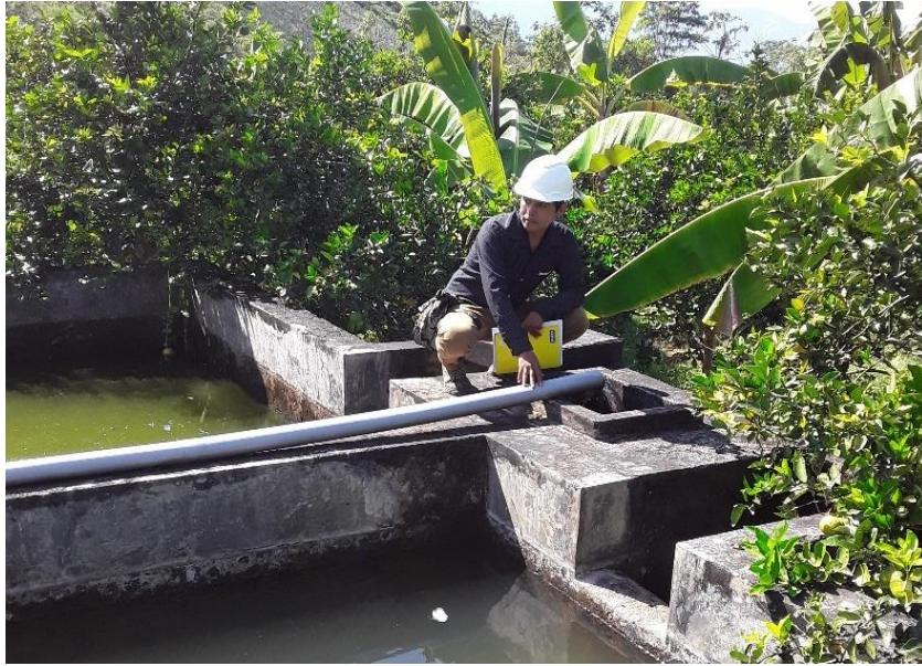
Ilustración 18. Inspección de Filtro Lento – pase directo.
