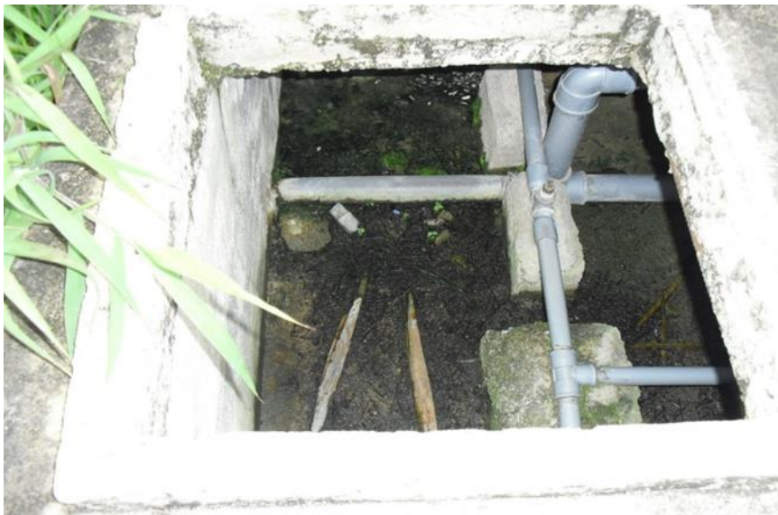
ANEXO 4. Caseta de Válvulas del reservorio de 5m 3 existente.
