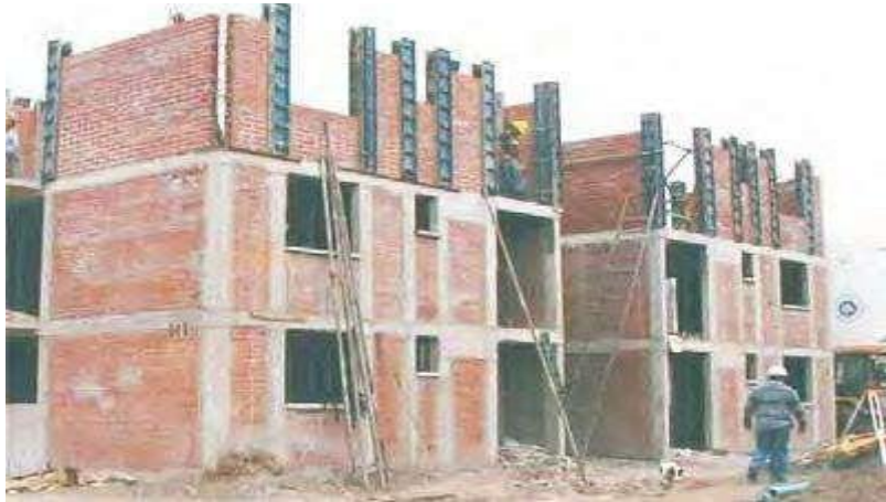
Gráfico 8: Albañilería confinada en proceso constructivo.
