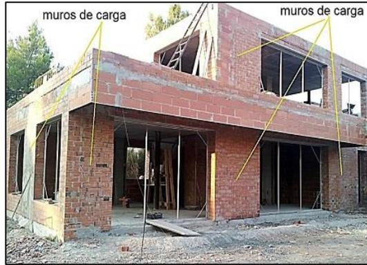
*Figura 11.* Imagen de muro portante
