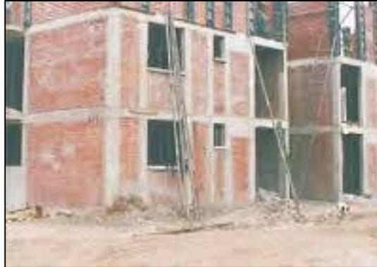
*Figura 3.* Imagen de albañilería confinada
