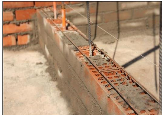
*Figura 2.* Imagen de albañilería armada
