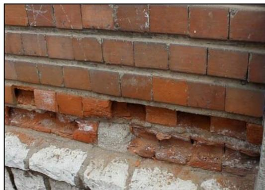
*Figura 13.* Imagen de erosión física
