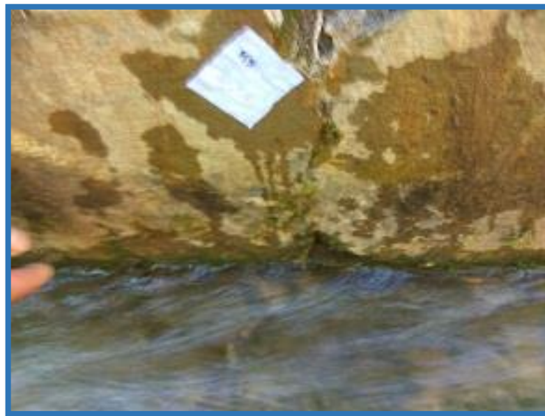
Gráfico 14: Eflorescencia en el canal de regadillo.
