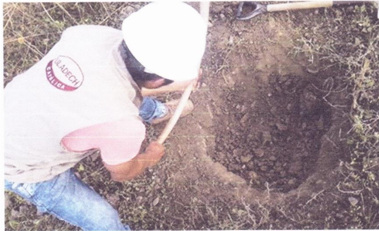
Foto N° 03.- Se aprecia en detalle una vista panorámica de la calicata C-04
