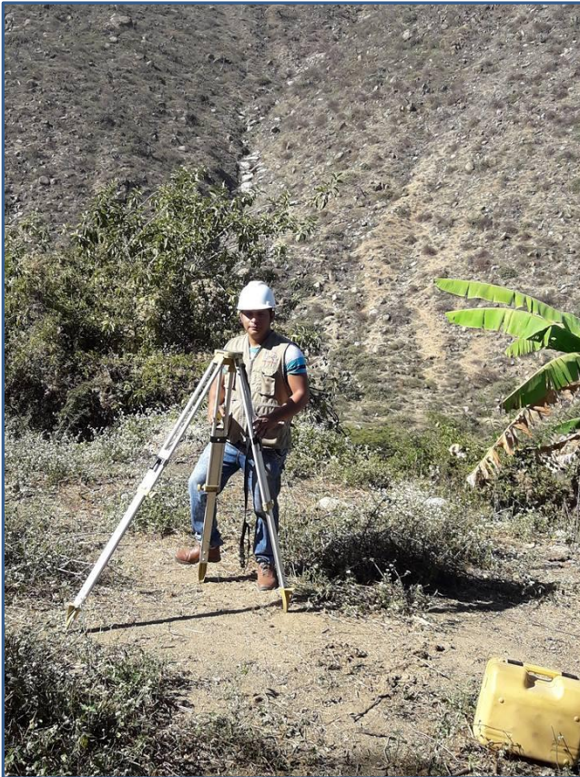
Fotografía 9: En la fotografía podemos apreciar, el proceso de trabajo que se está realizando con la estación total.
