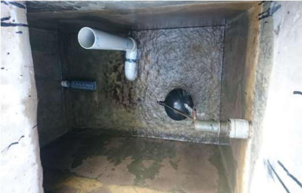
Imagen 17: Vista de control de rompe presión con válvulas de purga en buenas condiciones.
