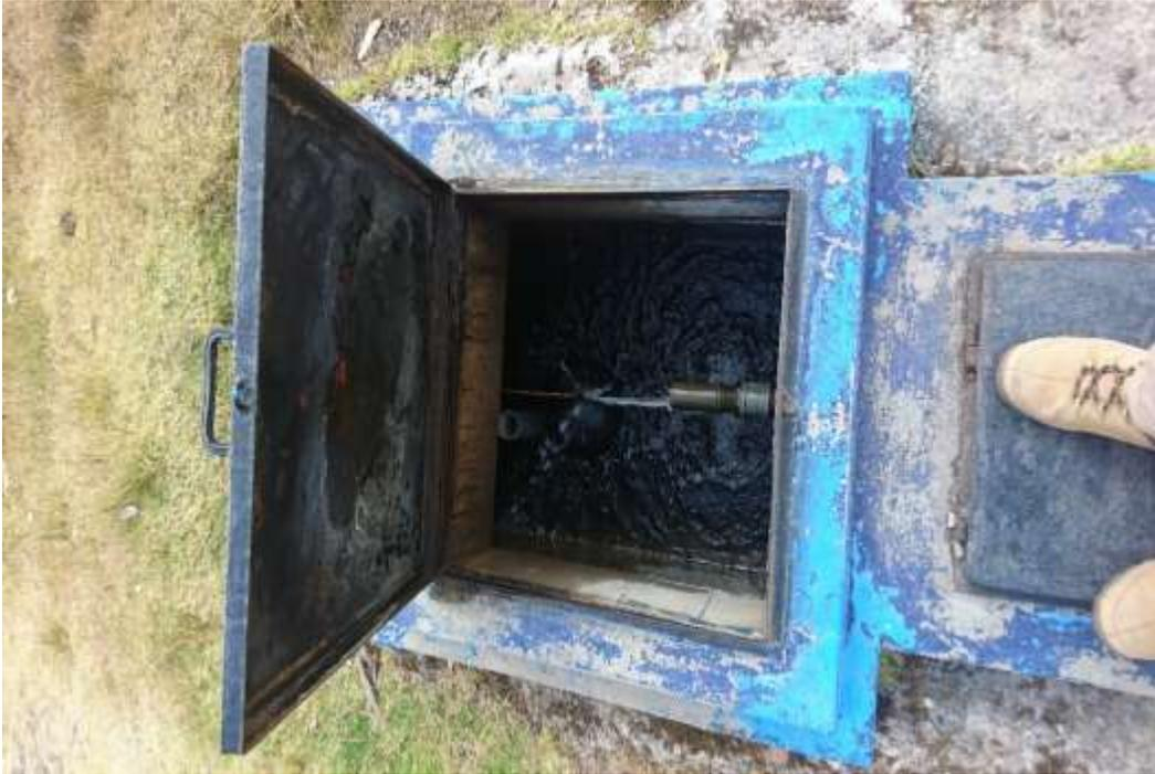
Imagen 15: Vista de control de rompe presión con control de flotador.
