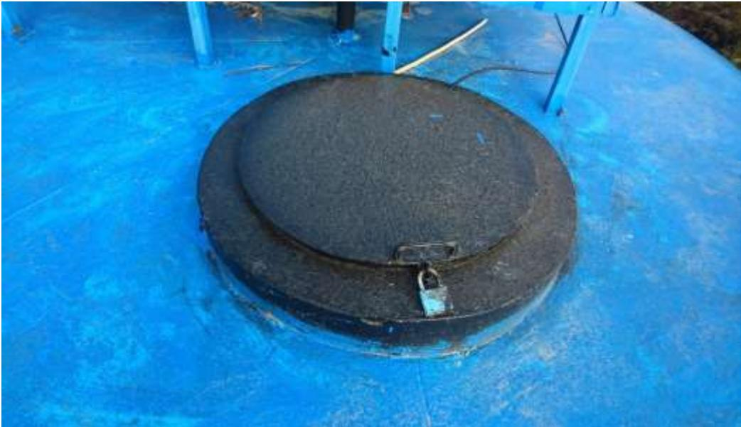
Imagen 11: Vista de tapas metálicas con seguridad del caja de válvulas del tanque de almacenamiento de agua potable de la comunidad de Huambo.
