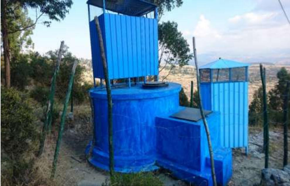
Imagen 7: Vista de caseta de cloración de agua potable en buenas condición
