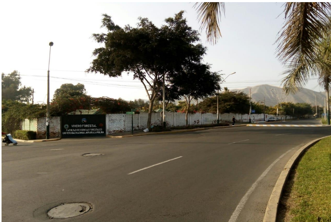
Fotografía 01: Vista panorámico colindante con la Calle el Establo (entrada principal).
