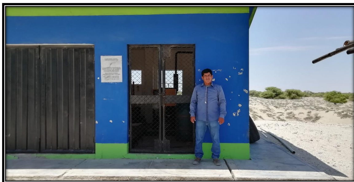
Imagen N° 55: Caseta de bombeo – Caserío Mala Vida
