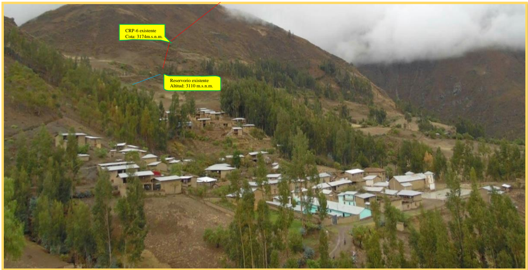
Imagen 02: Se puede apreciar una parte del trazo de la línea de conducción y aducción existente del sistema de abastecimiento de agua potable del caserío de Asay.
