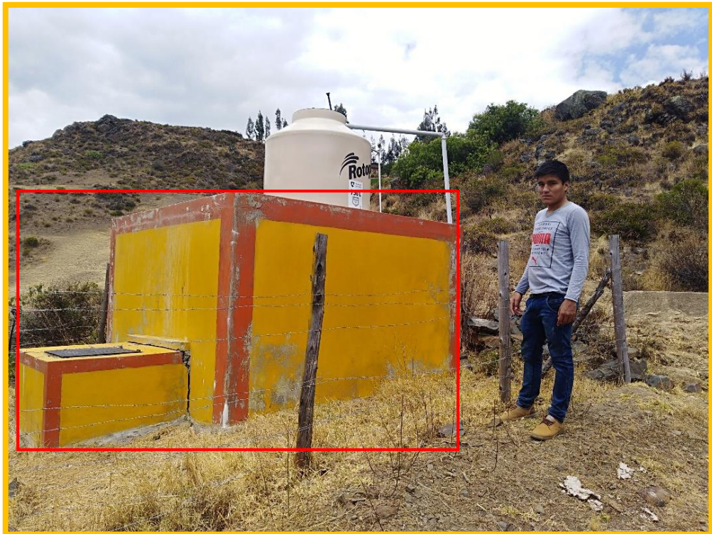
Imagen N° 09: Realizando la inspección en el reservorio de almacenamiento de agua potable y en la caja de válvulas.
