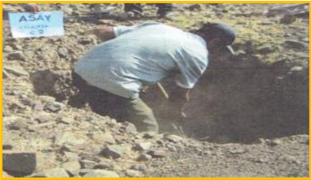
Imagen N° 17: Se observa realizando la calicata 2 de exploración subterránea en la localidad de Asay.
