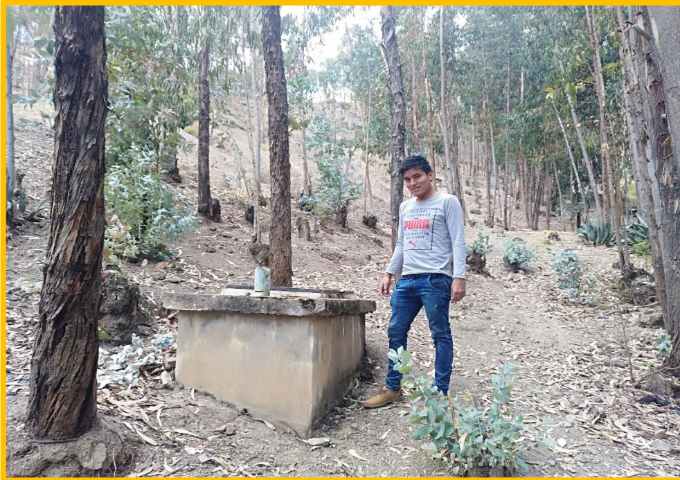
Imagen N° 13: Realizando la inspección en la cámara rompe presión 1 existente tipo 7 en el sistema de abastecimiento de agua potable.
