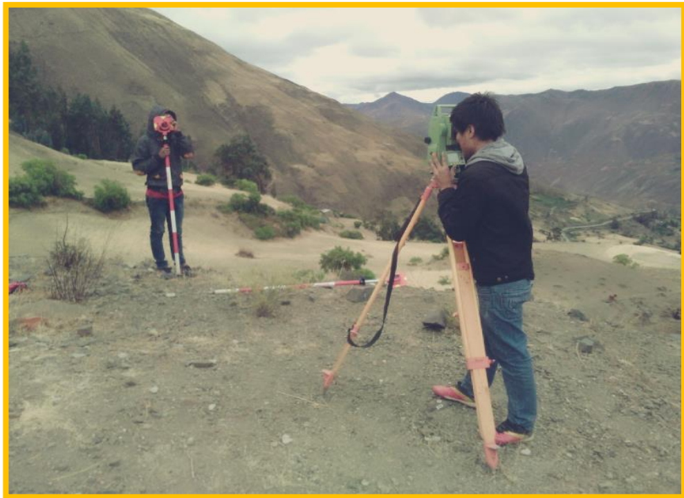
Imagen N° 07: Se puede apreciar tomando puntos con estación total en el sistema de abastecimiento de agua potable del caserío de Asay.
