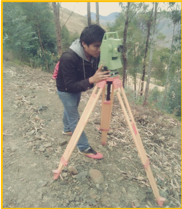
Imagen N° 05: Se observa realizando el levantamiento topográfico en el sistema de abastecimiento de agua potable del caserío de Asay.
