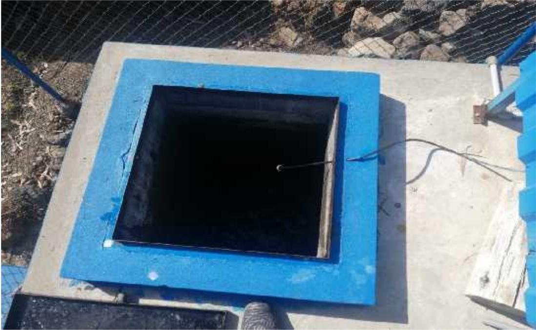
Imagen N° 13: Tapa sanitaria metálica abierta en el tanque de almacenamiento del reservorio de agua potable de la comunidad de Llullucha Ccata.
