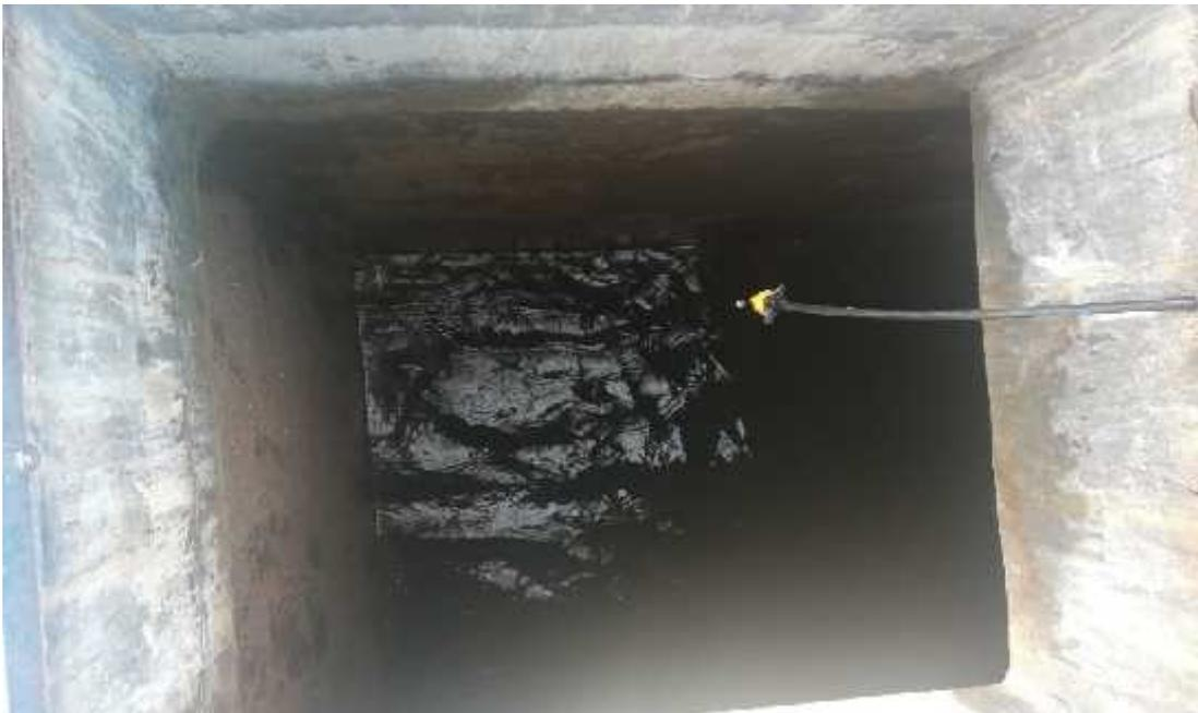
Imagen N° 14: Entrada de cloro por goteo, a través de una manguera de la caseta de cloración.
