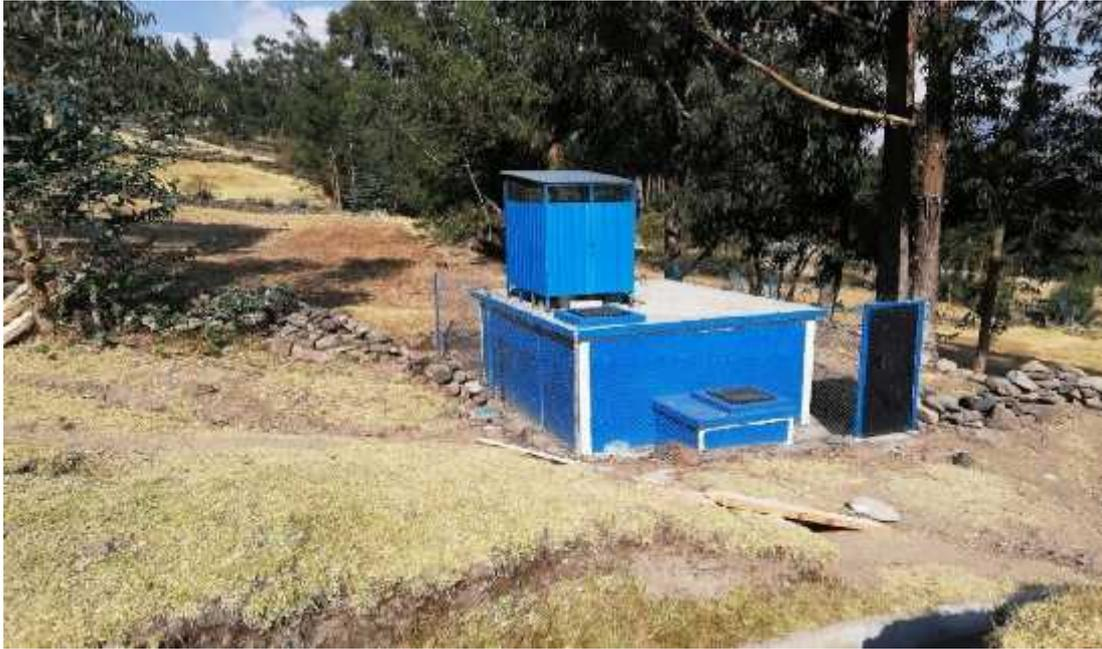
Imagen N° 07: Reservorio de agua potable de la comunidad de Llullucha Ccata. (volumen 15 m<sup>3</sup>). (Coordenadas UTM E: 582699.15, N: 8496545.18 - altitud 3369 msnm).
