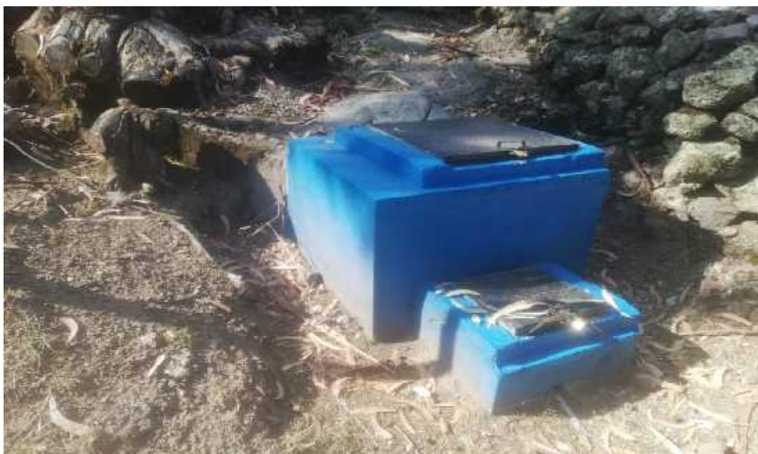
Imagen N° 06: Cámara rompe presión CRP 6, antes del reservorio en la comunidad de Llullucha Ccata. (altitud 3382 msnm).
