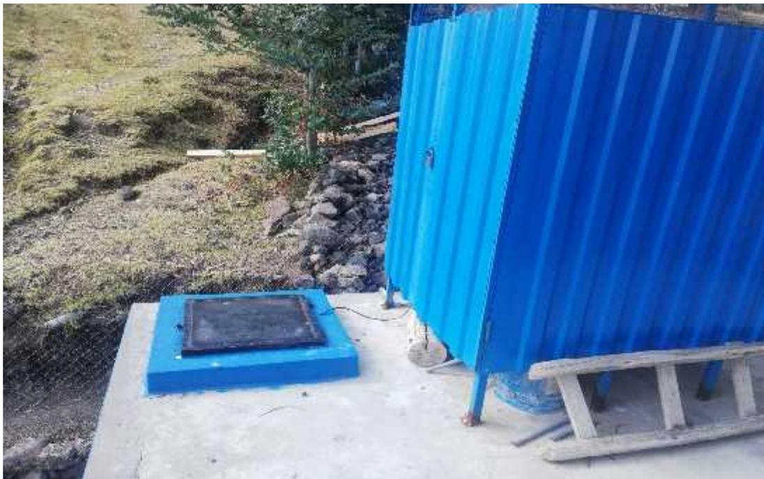
Imagen N° 12: Tapa sanitaria metálica en la caseta de cloración del reservorio de agua potable de la comunidad de Llullucha Ccata.
