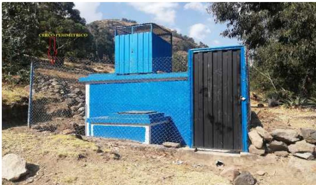
Imagen N° 08: Reservorio de agua potable de la comunidad de Llullucha Ccata. (volumen 15 m<sup>3</sup>). (Coordenadas UTM E: 582699.15, N: 8496545.18 - altitud 3369 msnm).
