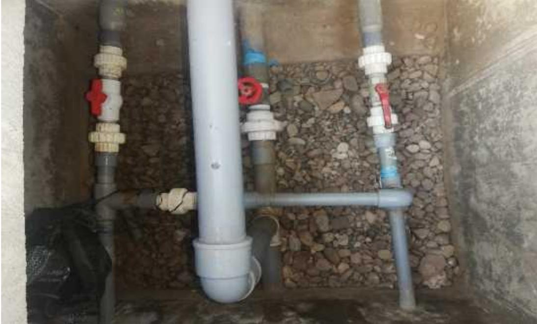
Imagen N° 10: Caseta de válvulas (tuberías entrada y salida) del reservorio de agua potable de la comunidad de Llullucha Ccata.
