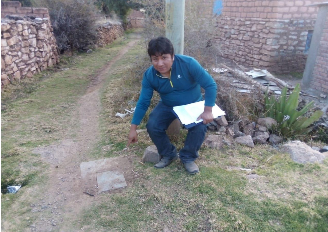
Fotografía N° 11: Caja de registro de agua y desagüe operativos Fuente: Registro propio (Insitu)
