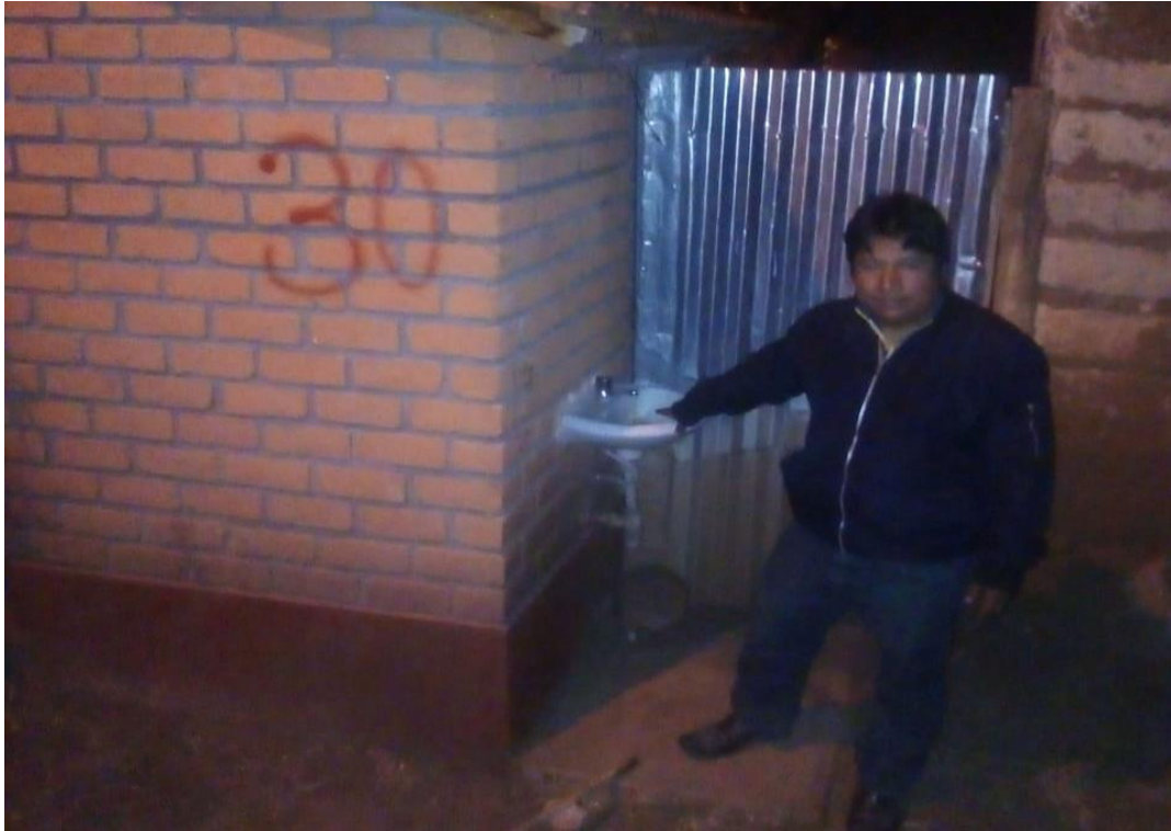
Fotografía N° 09: Lavamanos instalado en el domicilio de los usuarios Fuente: Registro propio (Insitu)
