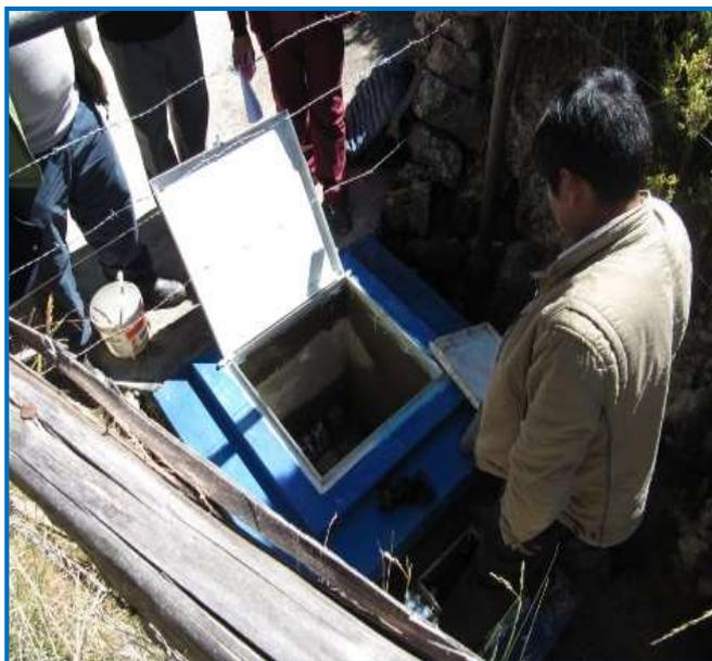
**Foto N° 04 Se observa el aforo de la captación principal de sistema del agua potable**
