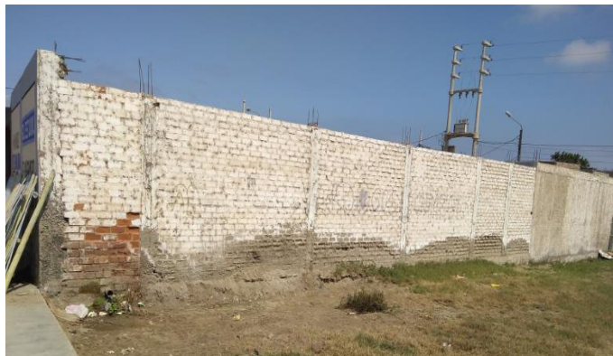
Figura 01. Cerco perimétrico de albañilería.
