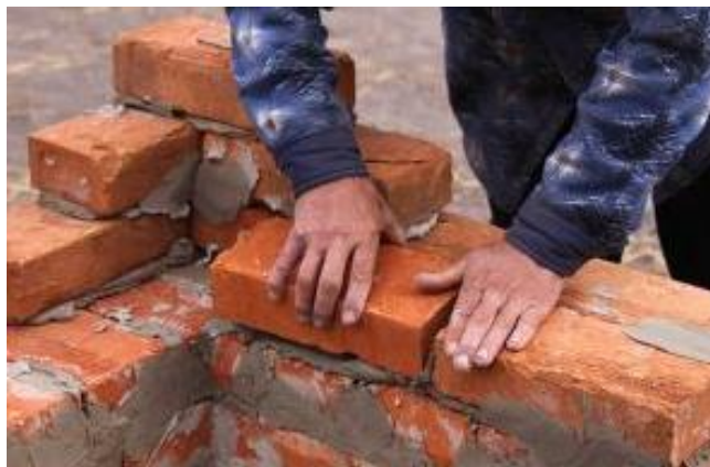
Figura 05. Construcción de muro con uso de albañilería simple.
