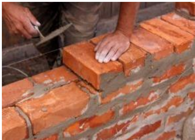
Figura 12. Albañil levantando muro de albañilería confinada.
