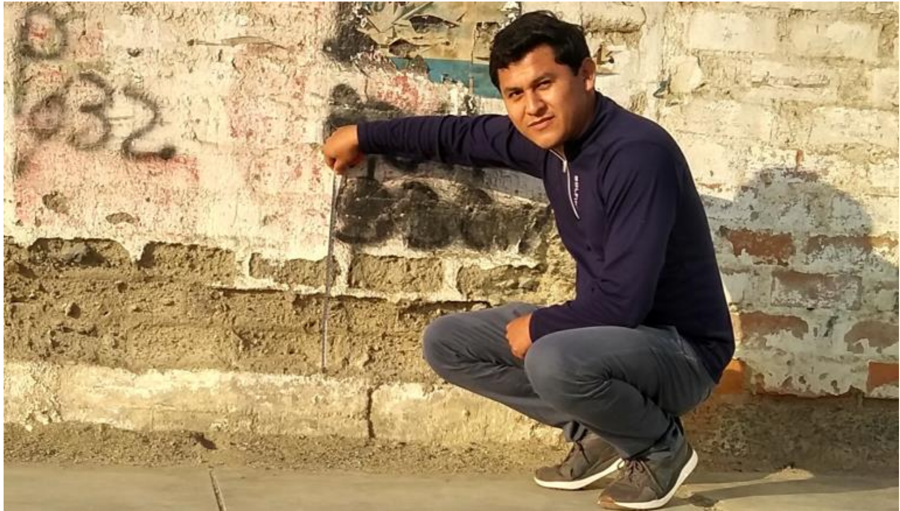
Fotografía 12: Muro de albañilería afectado por erosión química en la unidad muestral 04 con un porcentaje de área afectada por esta patología de 16.30%. El nivel de severidad de esta área en específica es alto.
