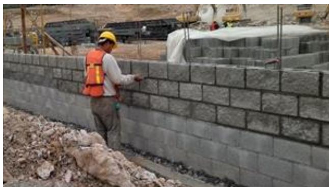
Figura 06. Construcción de muro con uso de albañilería armada.
