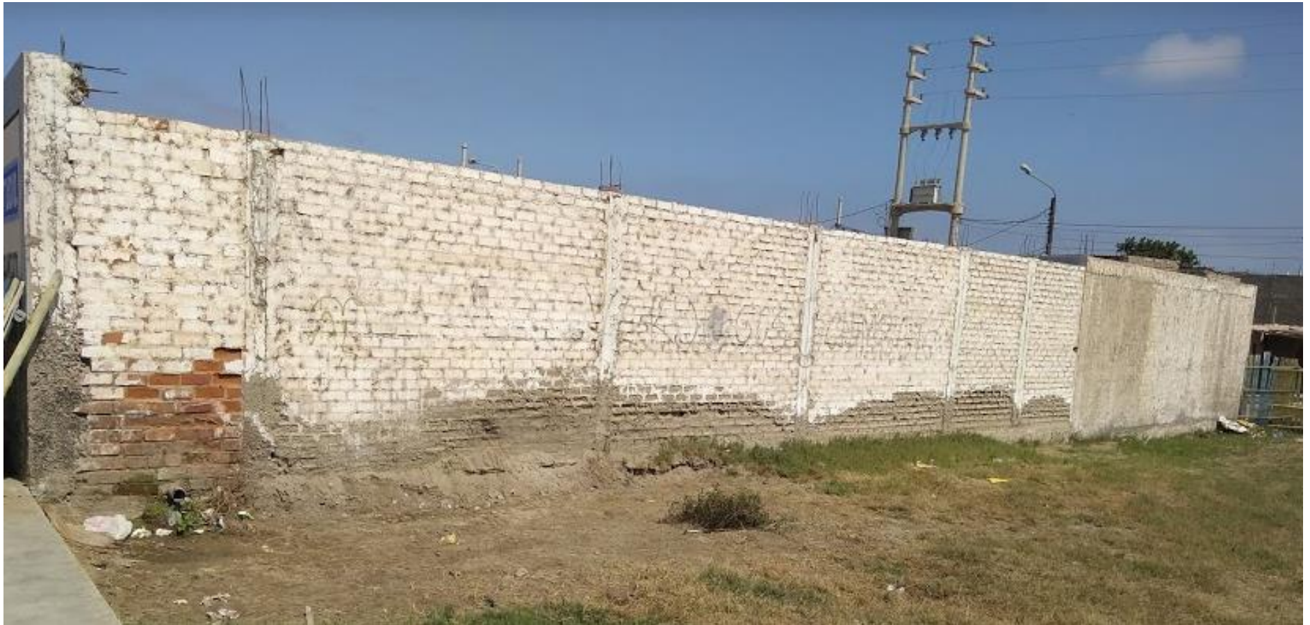
Fotografía 04: Vista exterior del tramo C – D del local comunal Golfo Pérsico, distrito Nuevo Chimbote, región Ancash.
