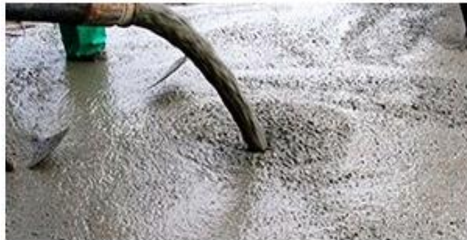
Figura 03. Concreto simple sin refuerzo.
