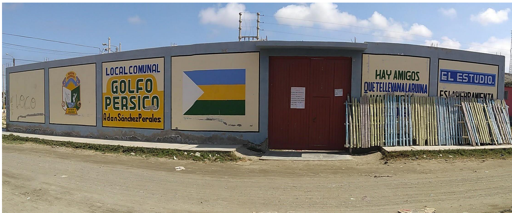
Fotografía 03: Vista exterior del tramo B - C del local comunal Golfo Pésico, distrito Nuevo Chimbote, región Ancash.
