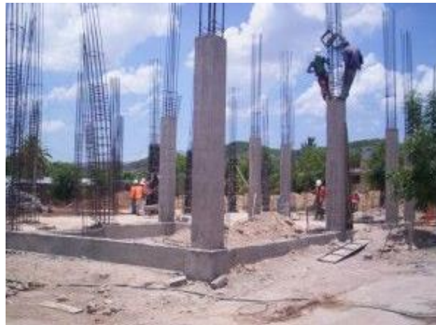
Figura 09. Columnas de concreto armado.
