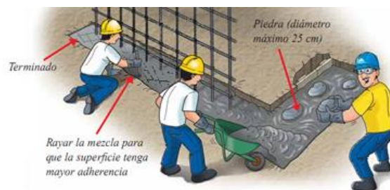
Figura 10. Vaciado de concreto para cimiento.
