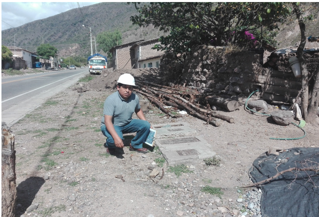
Figura 2.11: Conexiones domiciliarias.
