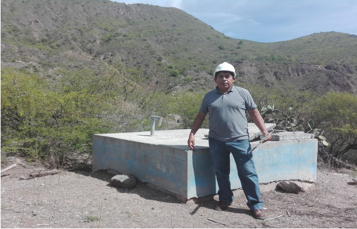
Fotografía 13: Vista frontal del reservorio.
