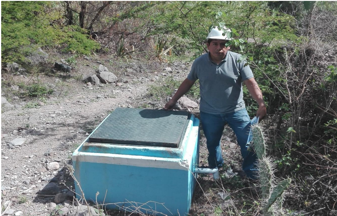
Fotografía 12: Vista lateral de la captación.
