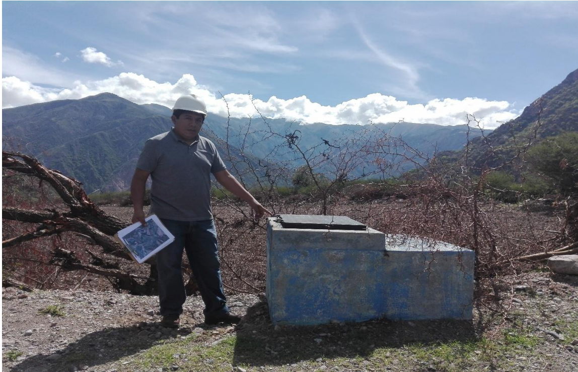
Fotografía 11: Vista frontal de la captación.
