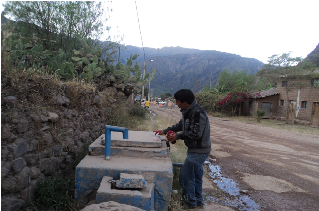
Figura 5.4: Ubicación de la Cámara rompe presión tipo 7 en la red de distribución.
