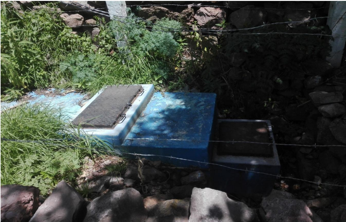
Fotografía 16: Vista lateral de la captación.
