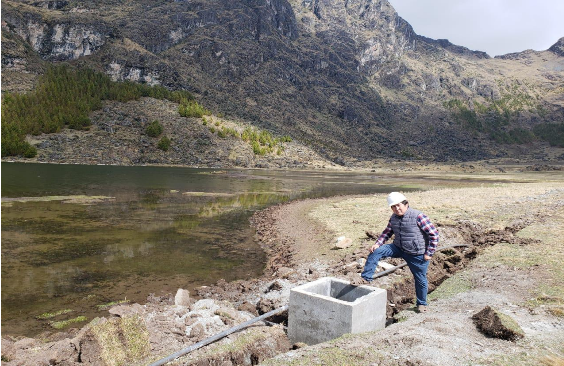
Fotografía 10: Vista lateral de la línea de conducción.
