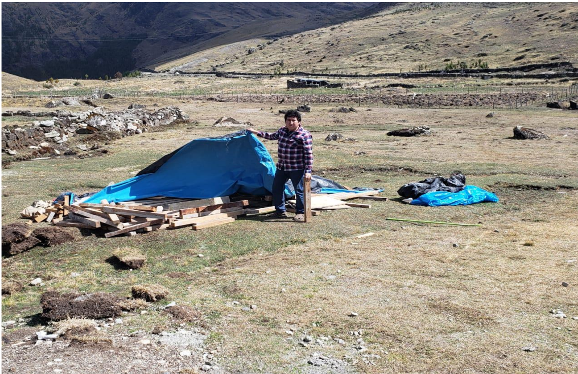
Fotografía 11: Madera para el encofrado.
