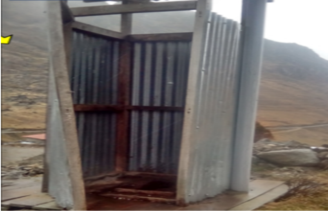
Figura 2.14: Baño de hoyo seco ventilado.
