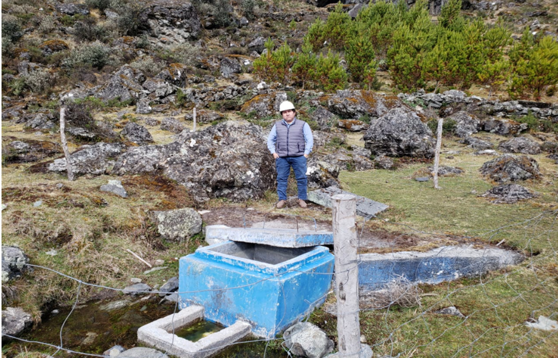
Figura 2.2: Vista externa de una captación.
