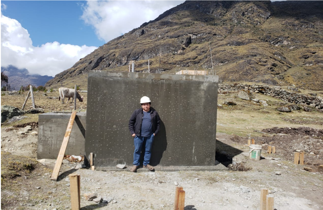
Figura 2.7: Reservorio en construcción.
