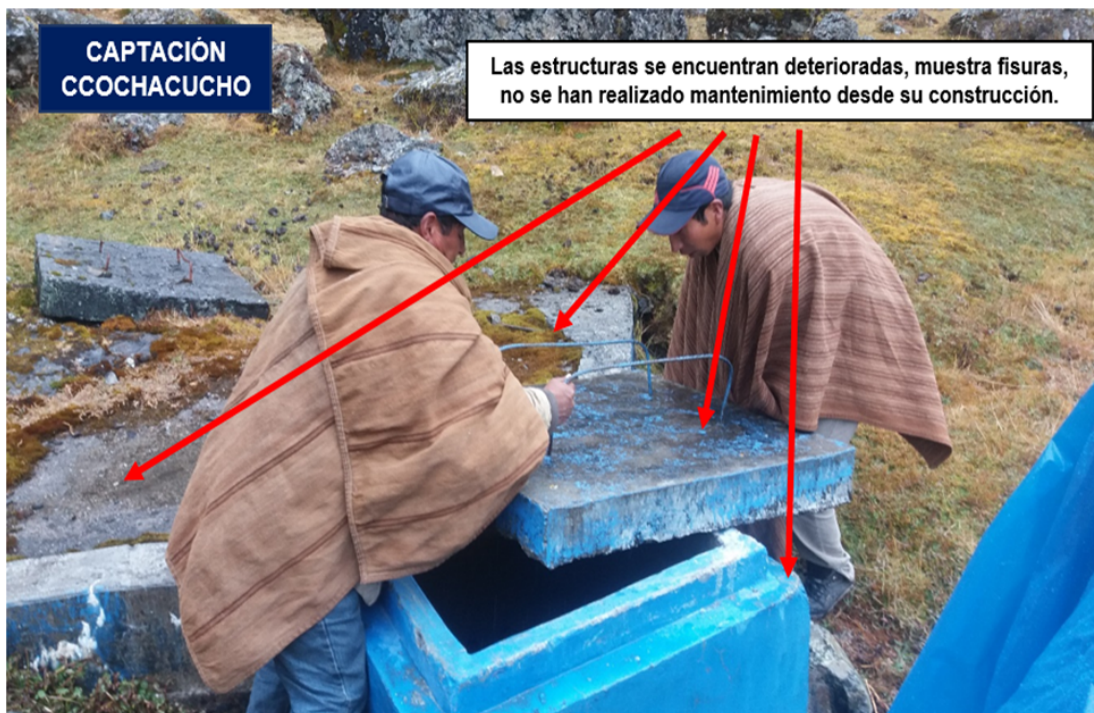
Figura 5.5: Vista de la captación manantial actual.
