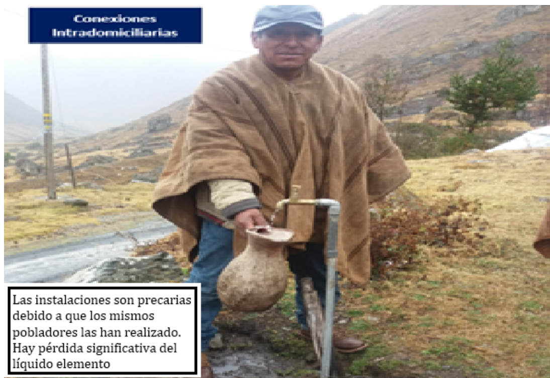
Figura 5.18: Situación actual de las conexiones domiciliarias.
