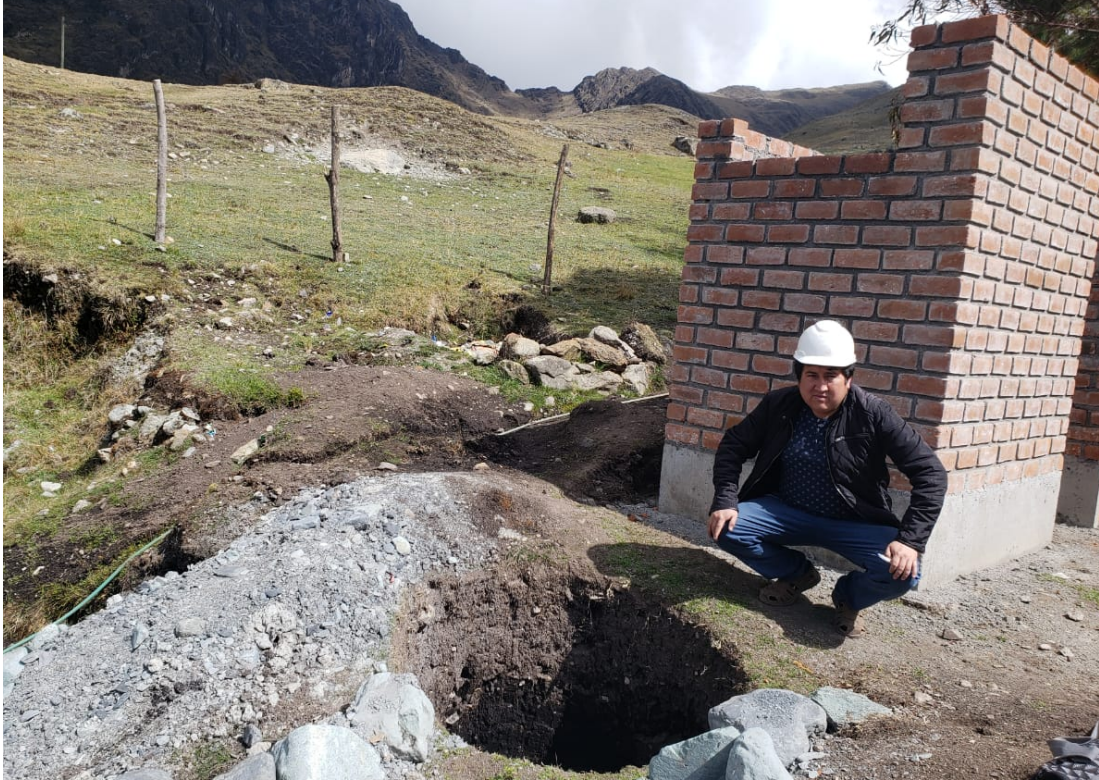
Figura 2.19: Conexión domiciliaria en construcción.
