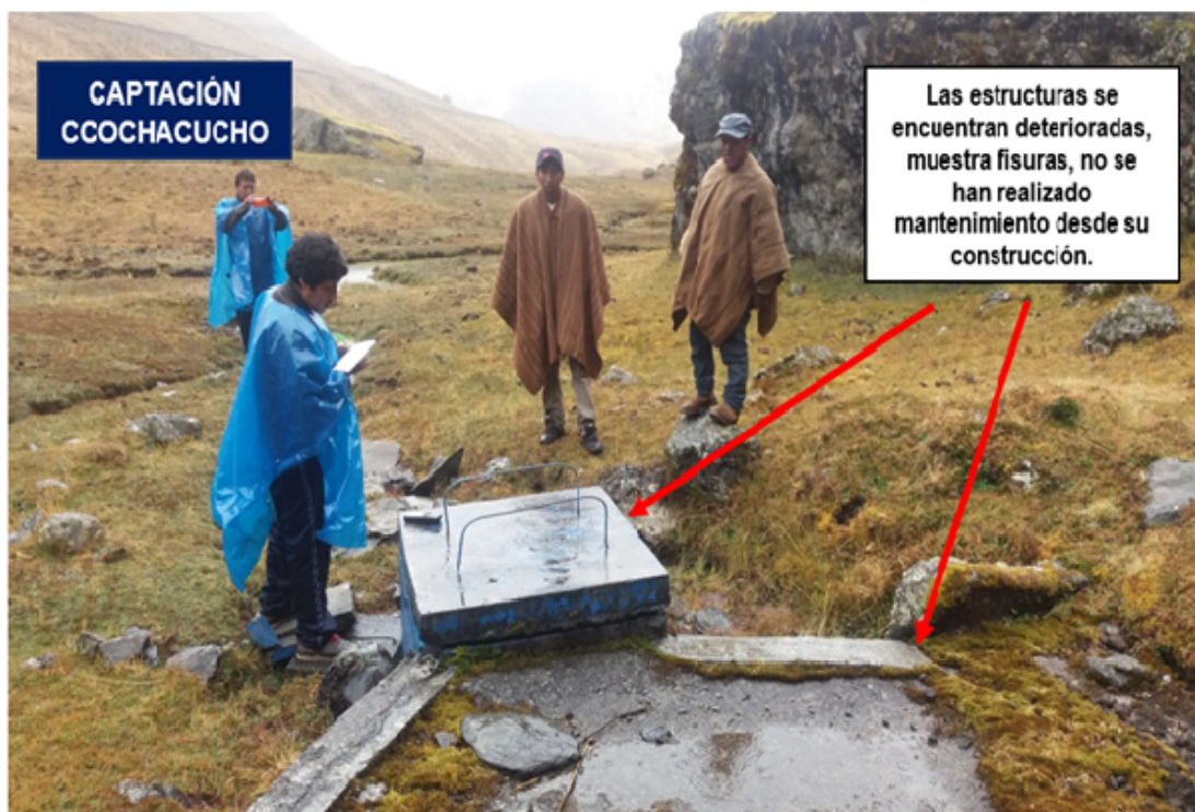
Figura 5.4: Vista de la captación manantial actual.
