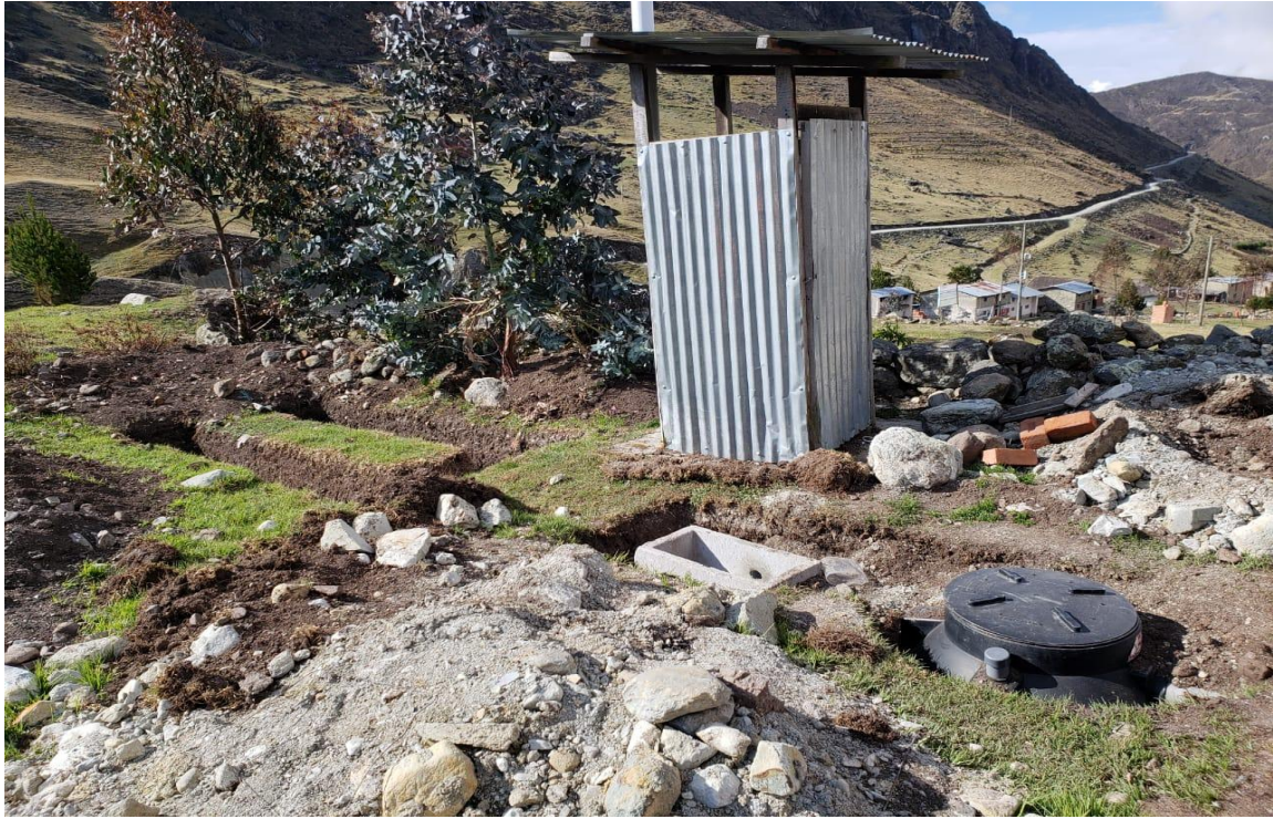
Fotografía 04: Vista lateral de una letrina artesanal.
