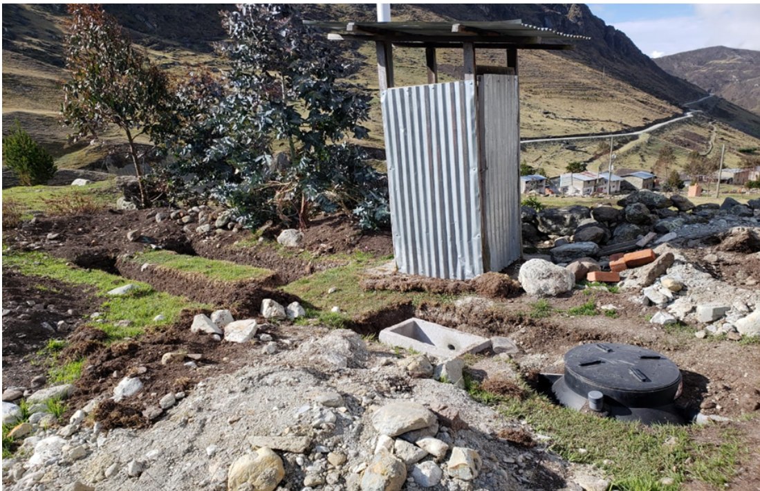
Figura 2.13: Construcción de alcantarillado.
