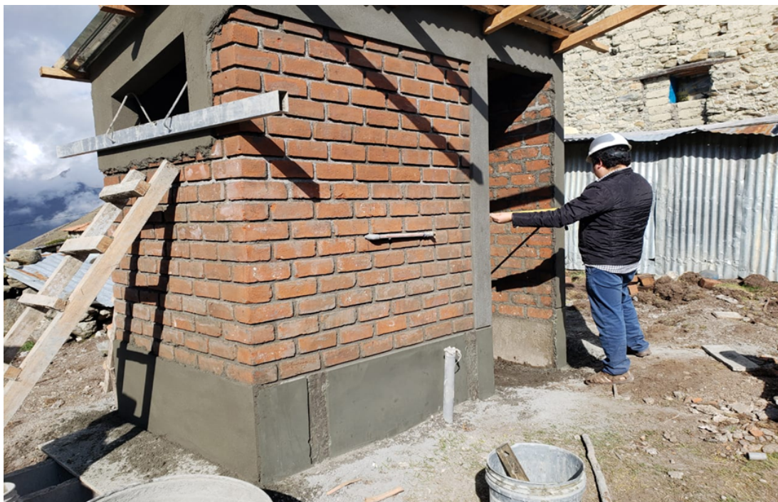
Figura 2.1: UBS en proceso de construcción.
