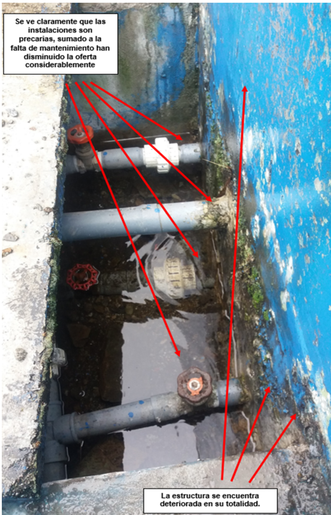
Figura 5.17: Situación actual del Reservorio.
