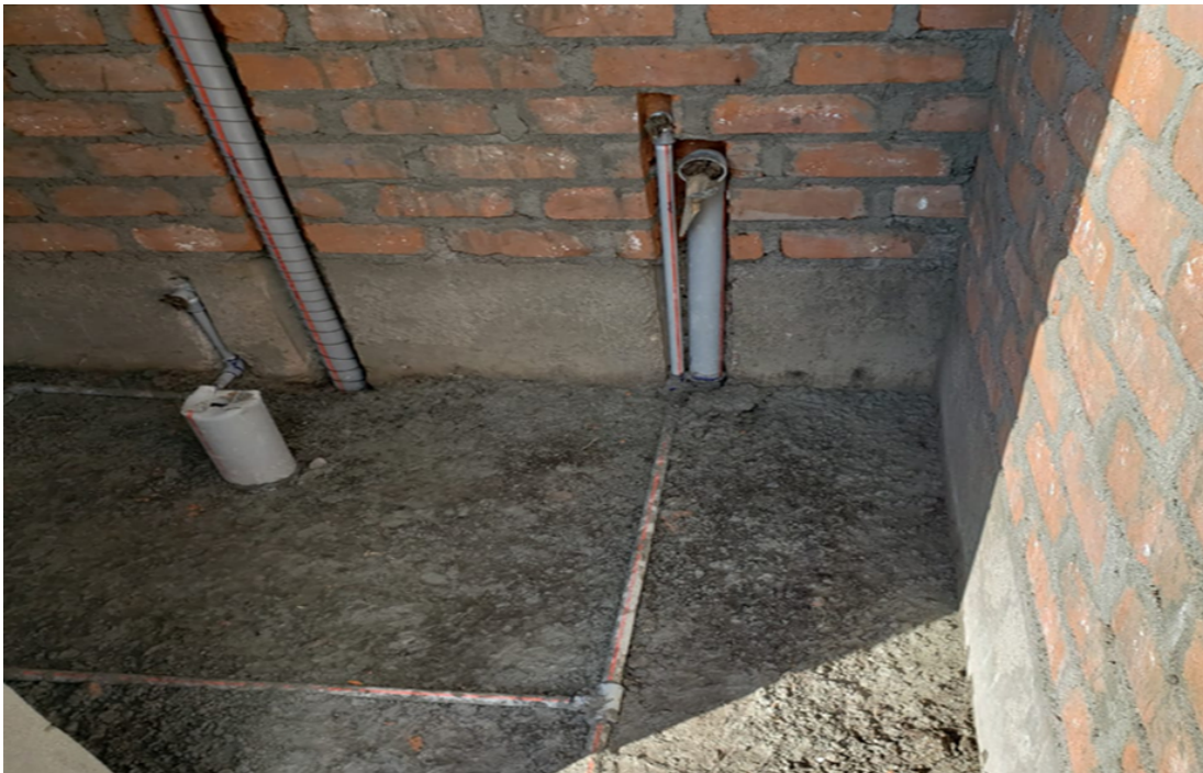
Figura 2.10: Válvula de paso en construcción.
