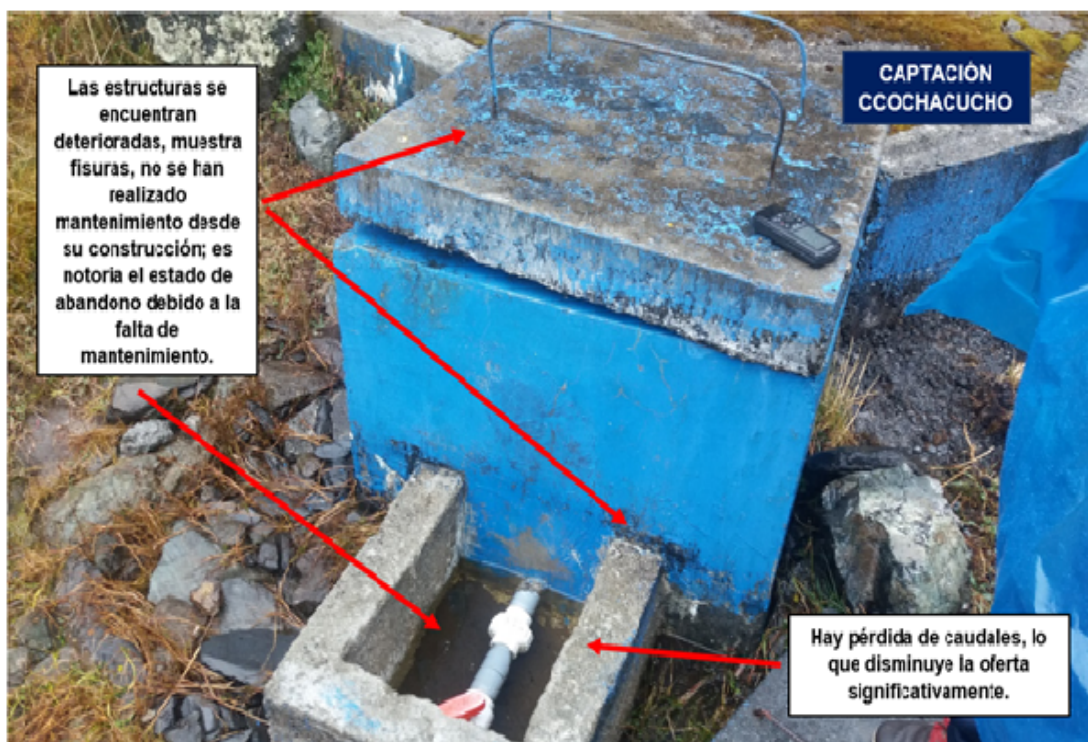
Figura 5.3: Vista de la captación manantial actual.
