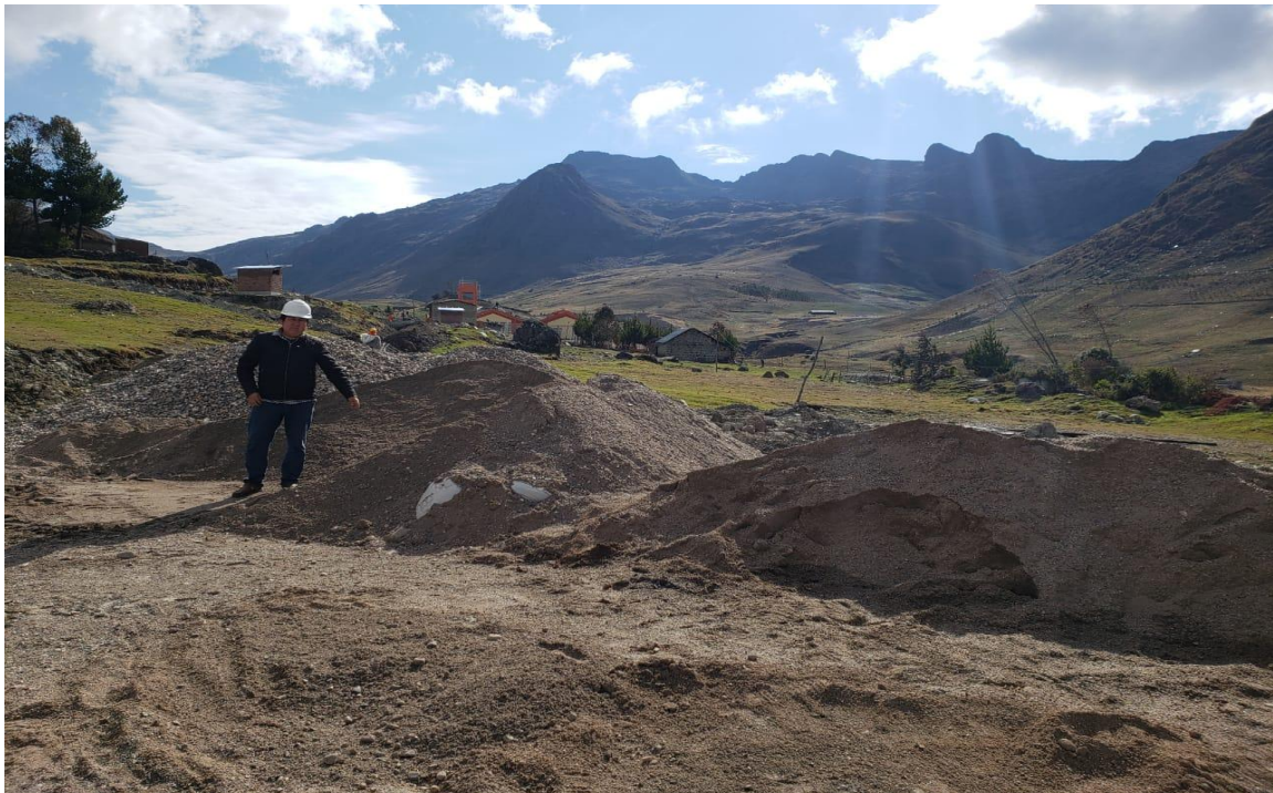
Fotografía 07: Piedra chancada y arena fina para la construcción del reservorio.
