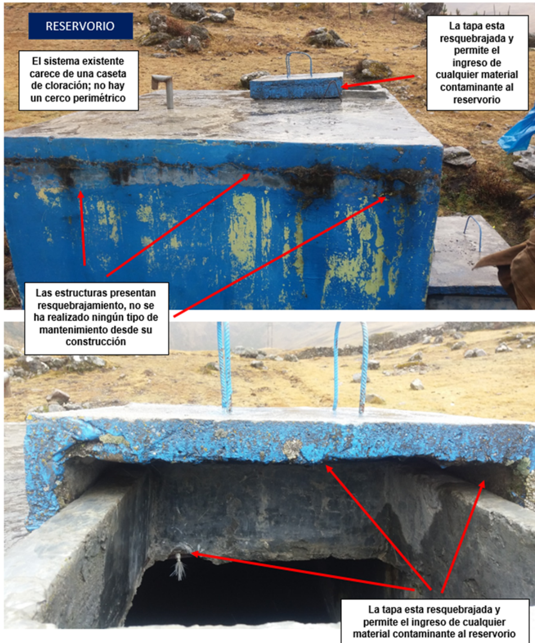
Figura 5.13: Situación actual del Reservorio.
