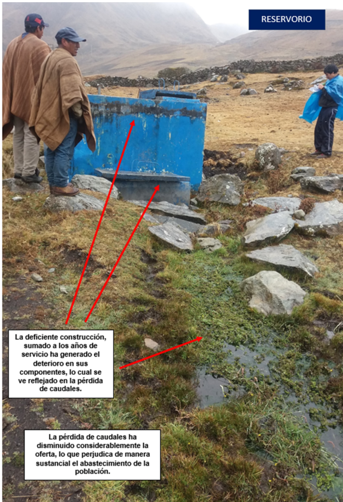
Figura 5.16: Situación actual del Reservorio.
