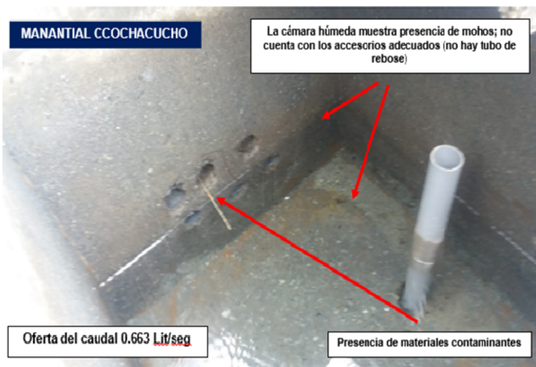
Figura 5.6: Vista de la captación manantial actual.
