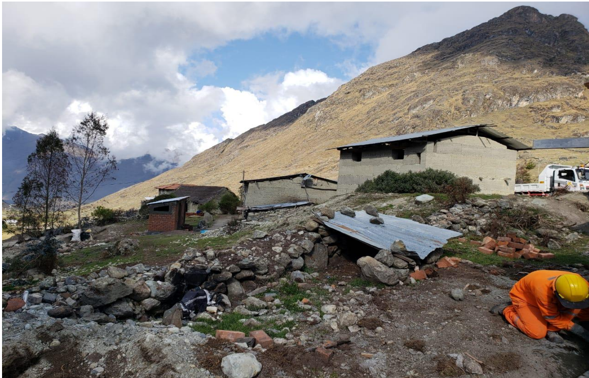
Fotografía 05: Viviendas típicas de la zona.
