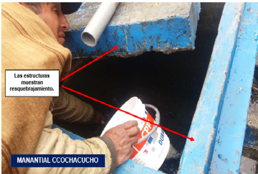
Figura 5.7: Vista de la captación manantial actual.
