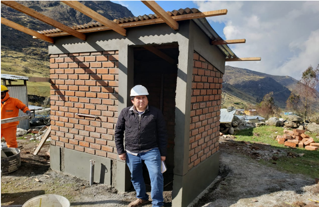
Figura 2.18: UBS en construcción donde se instalará el retrete de tanque.
