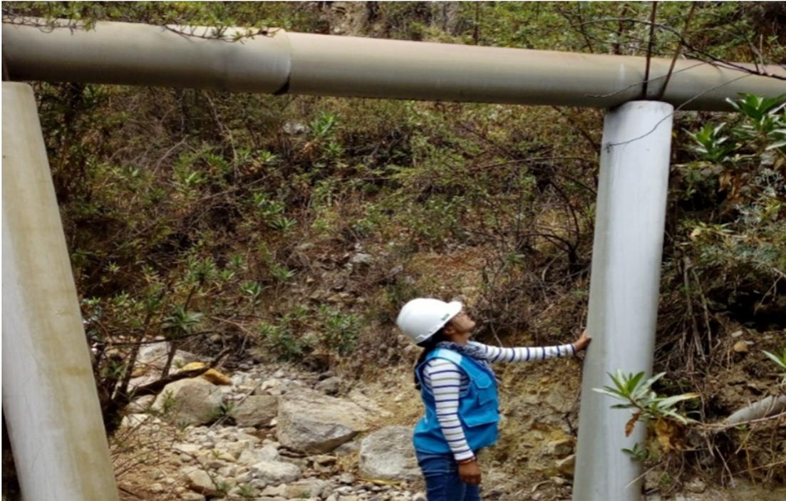
Figura 2.2: Línea de conducción en pésimo estado.
