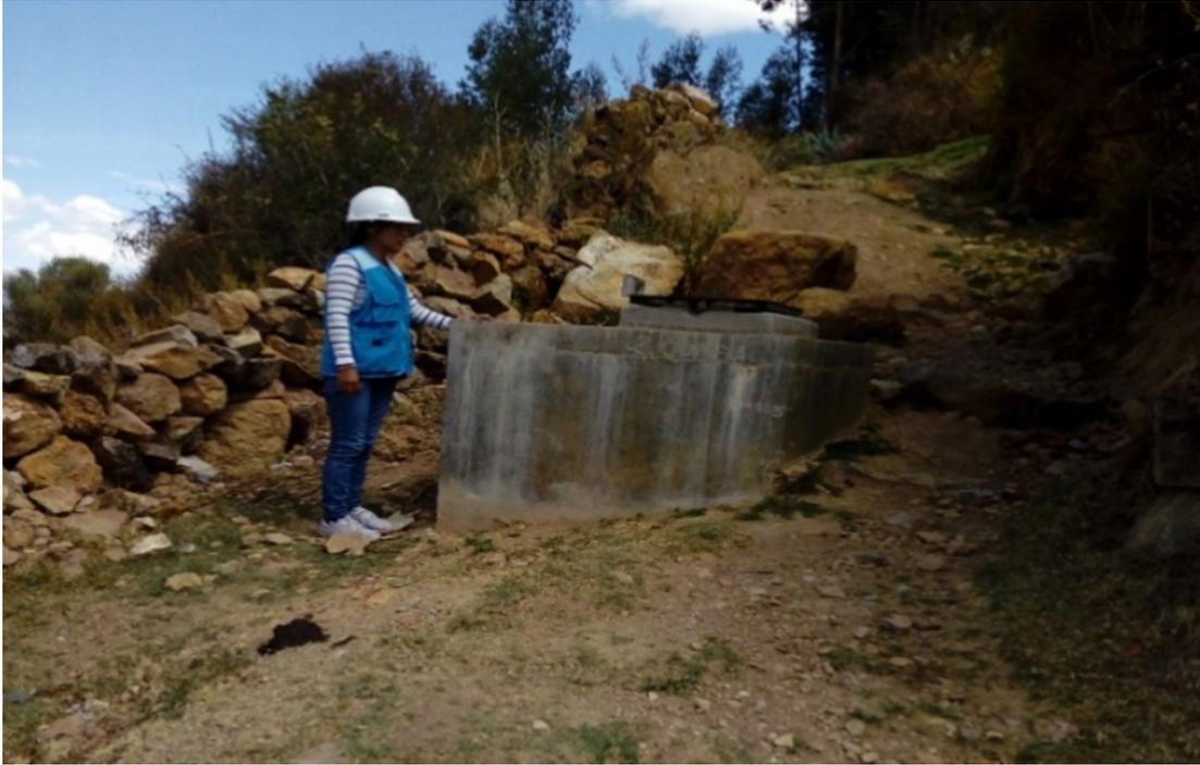
Figura 2.3: Cámara rompe presión tipo 6.
