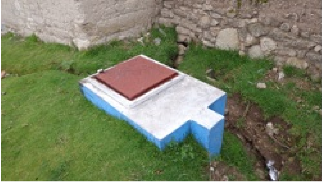
Figura 2.2: Cámara rompe presión tipo 6.
