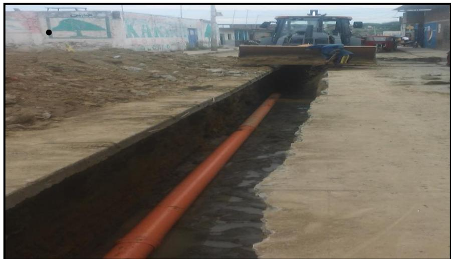
Figura 4: Colector Secundario de Ø 8" PVC
