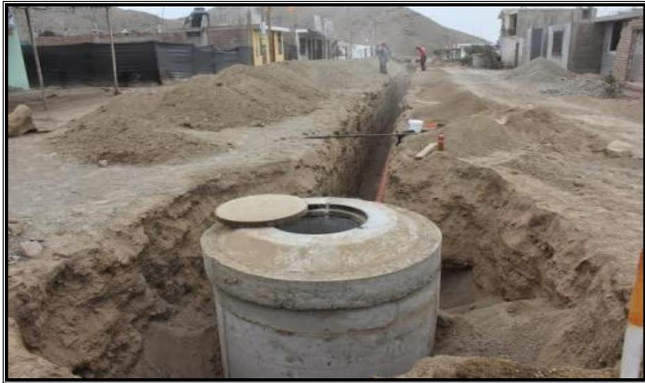
Figura 8: buzón Instalado en Obra
