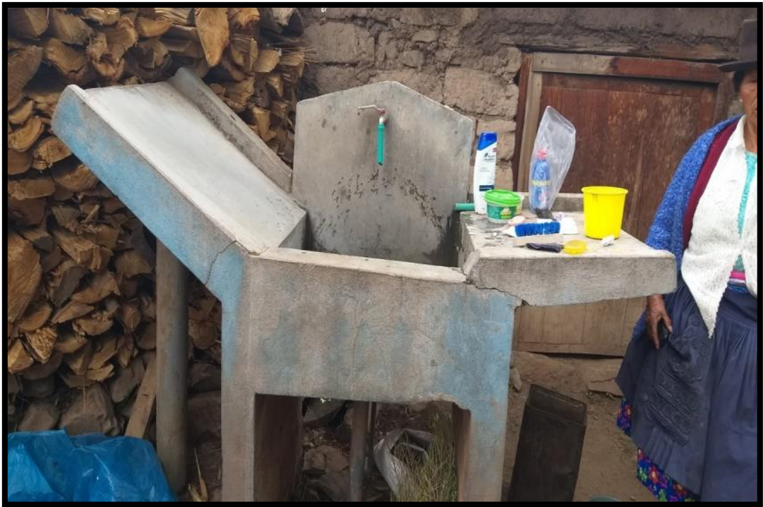
Foto 9: vista de lavadero
