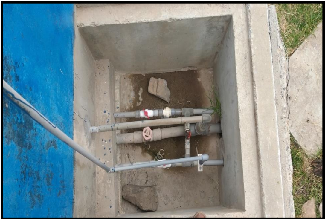
Foto 8: Fotografía N° 08: vista de la caja de válvula del reservorio
