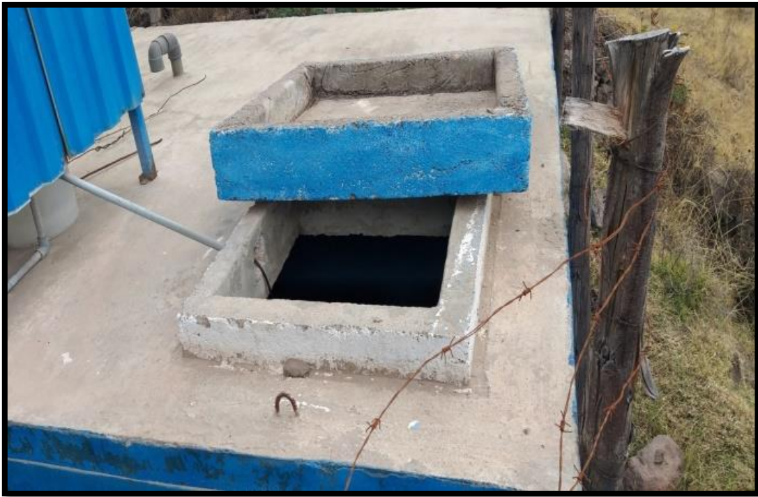
Foto 7: vista de la tapa sanitaria del reservorio
