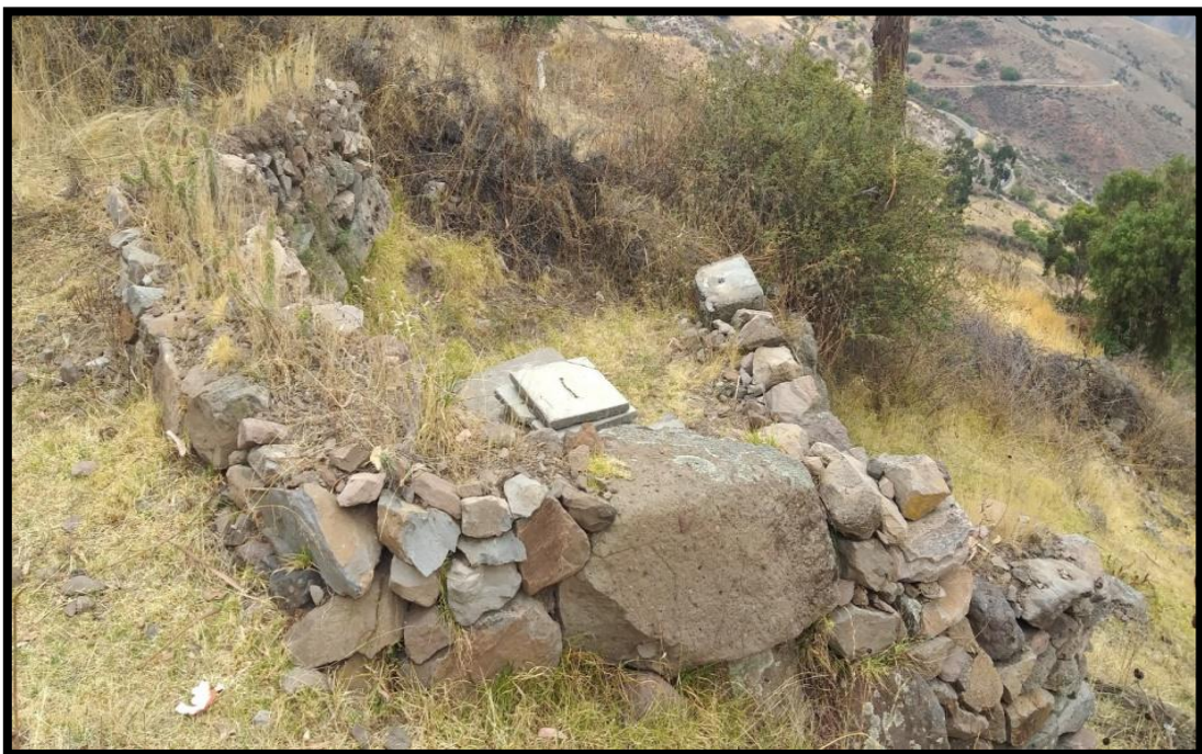
Foto 4: cerco perimétrico de la captación con muros de piedra.
