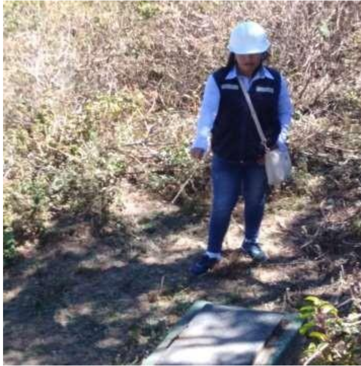
IMAGEN. CAJA DE CAPTACION EXISTENTE
